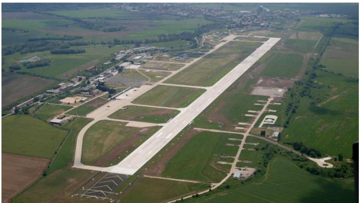
Obr. 13: Letisko Sliač, pohľad z výšky [33]
