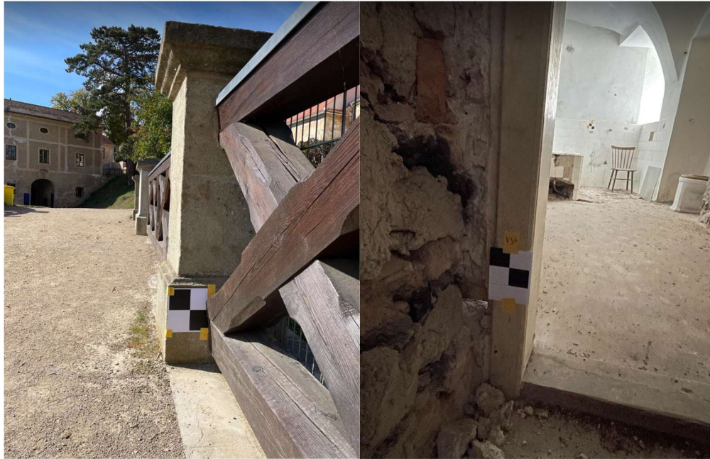
Obrázek 11 - Ukázka rozmístění vřícovacích a kontrolních bodů
