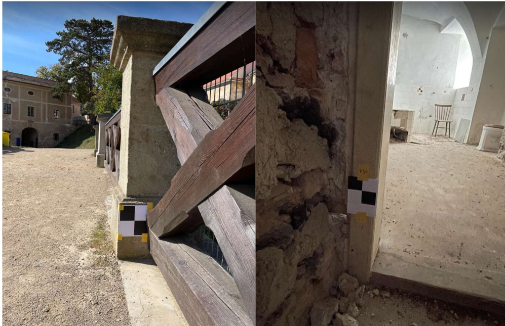
Obrázek 11 - Ukázka rozmístění vřícovacích a kontrolních bodů
