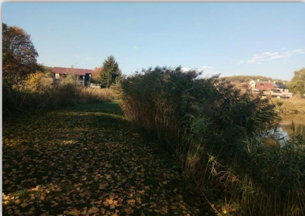
Obr. 36: Vodohospodářská opatření – přístup k hrázi rybníka (autor, 2018)
