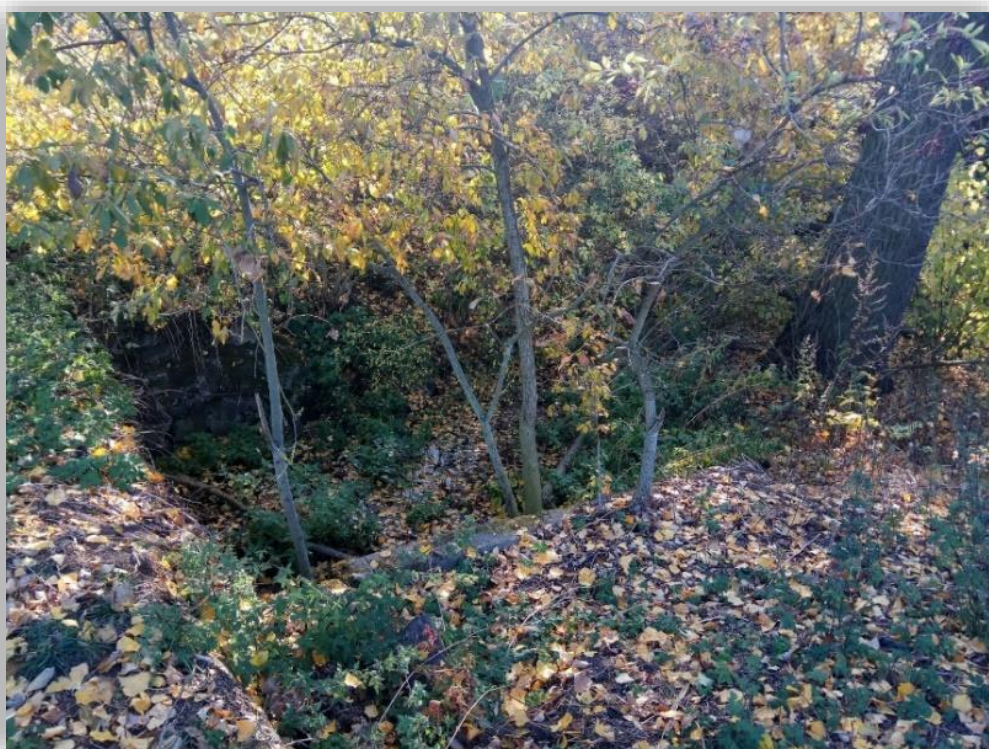
Obr. 37: Vodohospodářská opatření – výpustní objekt (autor, 2018)
