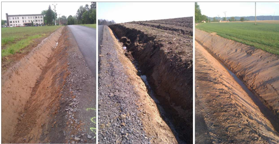
Obr. č. 19 b: Stavba asfaltových polních silnic, Zdroj: Vaniček 2015
