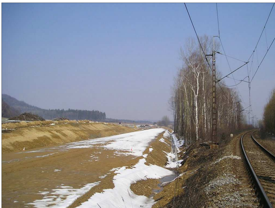
Obr. č. 20: Modernizace železnice Třebovice – Rudoltice, Zdroj: Zelpage
