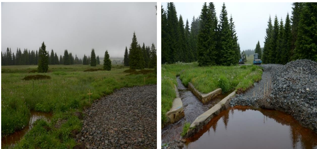
Obrázek 15 a 16: Stavba stezky podél Blatenského vodního příkopu (Malina 2018)
