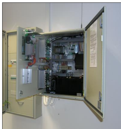
Obrázek 7: Ovládací skříň elektronické sirény. Zdroj: [06]
