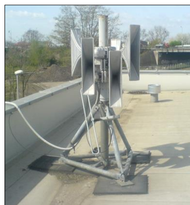
Obrázek 6: akustická část elektronické sirény (horny). Zdroj: [07]
