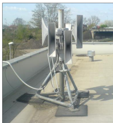
Obrázek 6: akustická část elektronické sirény (horny). Zdroj: [07]
