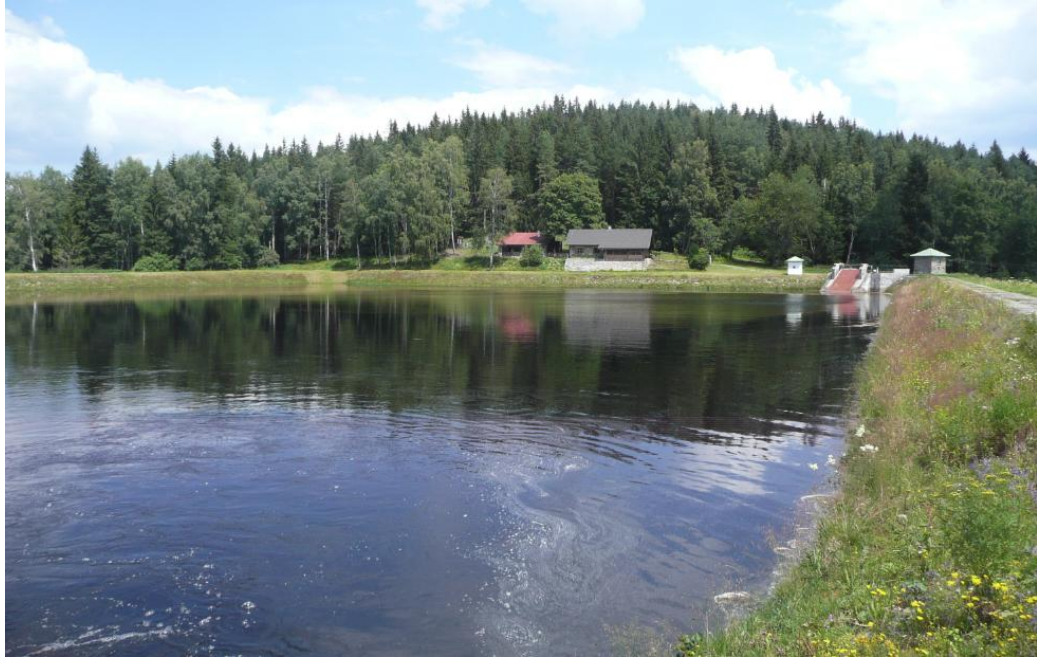
Obr. č. 24 Akumulační nádrž Sedlo
