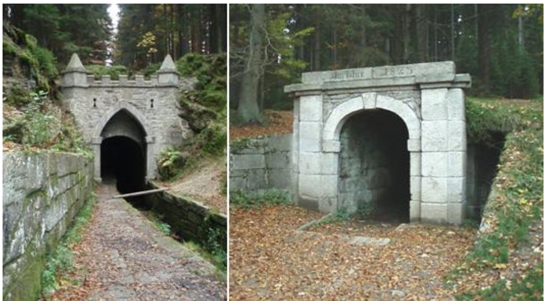
Obr. č. 13 Portály tunelu: horní (vlevo) a dolní (vpravo)
