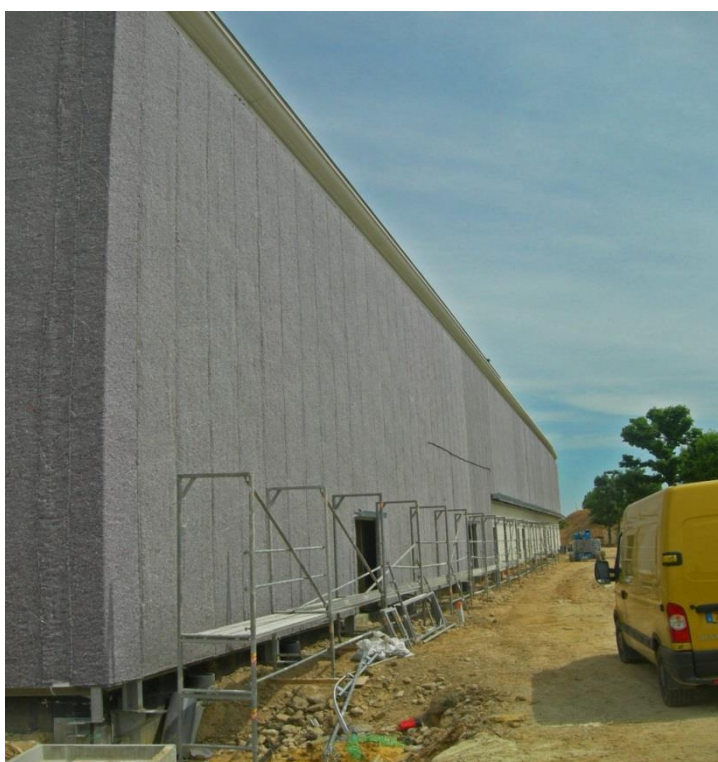
Obrázek 8: Vrstva netkané textilie při instalaci vertikální zahrady
