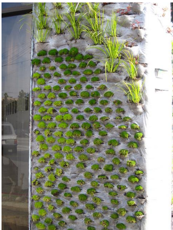
Obrázek 9: Rostliny vložené do systému vertikální zahrady
