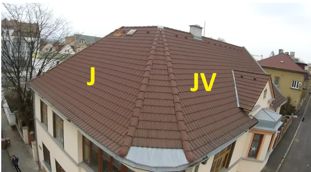
obr. 12 Plocha střechy navržená pro instalaci FVE
