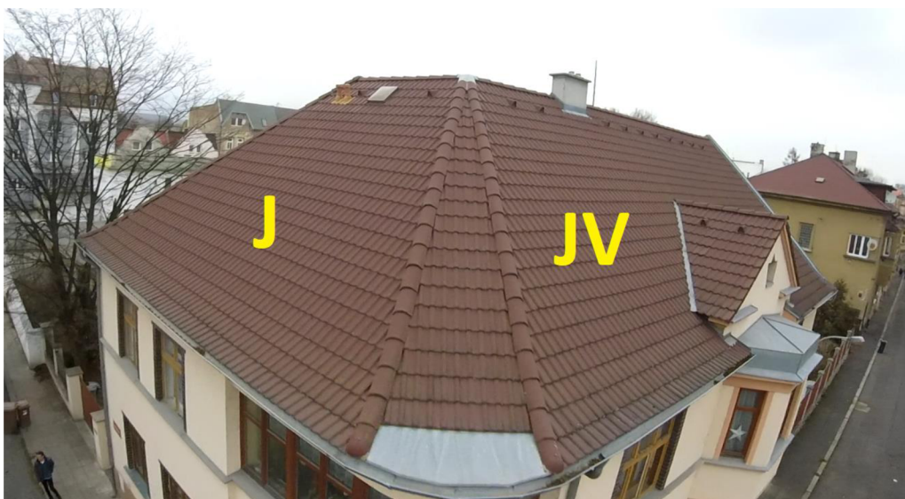
obr. 12 Plocha střechy navržená pro instalaci FVE
