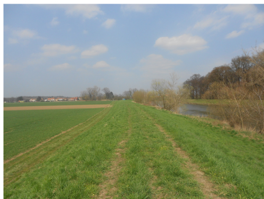
Přilehlé agrocenózy a protipovodňová hráz na Úseku č. 6
