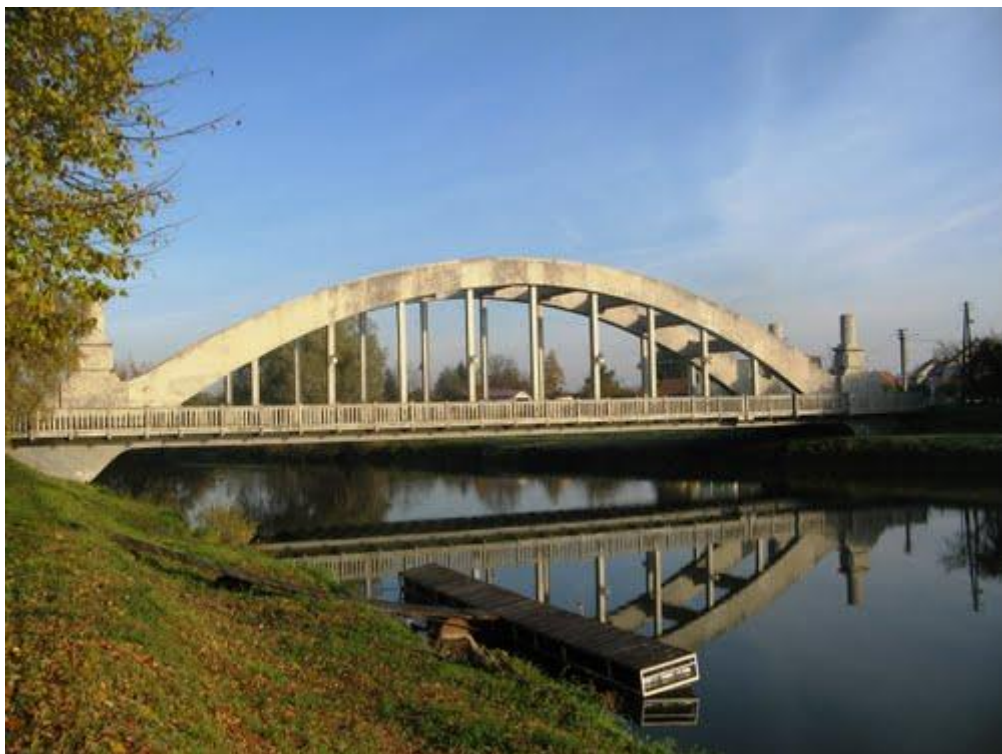
Obr. 1/ Most přes řeku Moravu v Uherském Ostrohu
