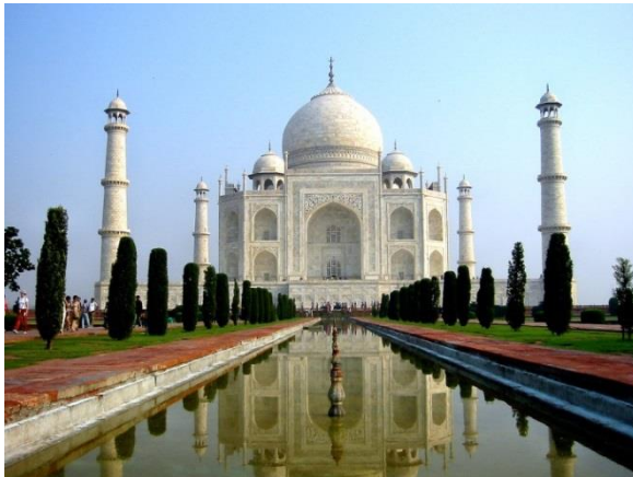
Obr. č. 1: Mauzoleum Taj Mahal v Agře
