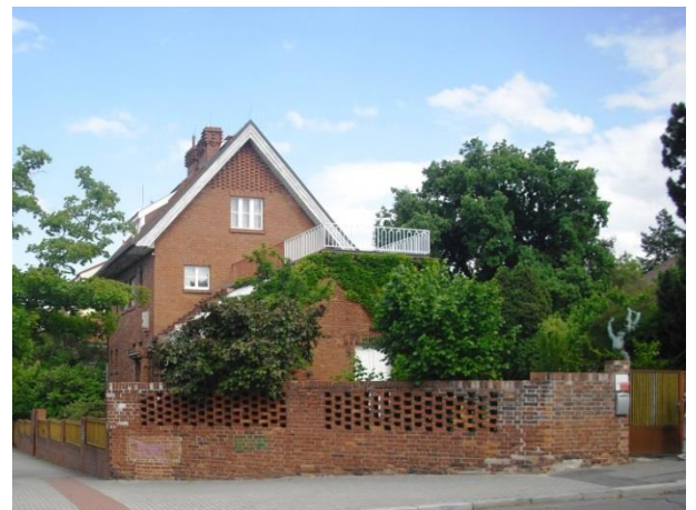
Obr. č. 30: Pohled na Kafkovu vilu z Lomené ulice
