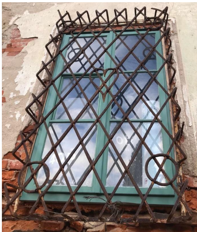
Obr. č. 30 Jediná mříž dochovaná na jižní straně kratšího křídla. Ve všech čtyřech rozích této mříže jsou rozmístěny kruhy a uprostřed srdce.
