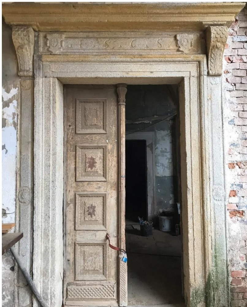
Obr. č. 26 Vstupní portál vedoucí do přízemí bočního křídla s datací 1565. V portálu jsou osazeny vyřezávané klasicistní dveře.
