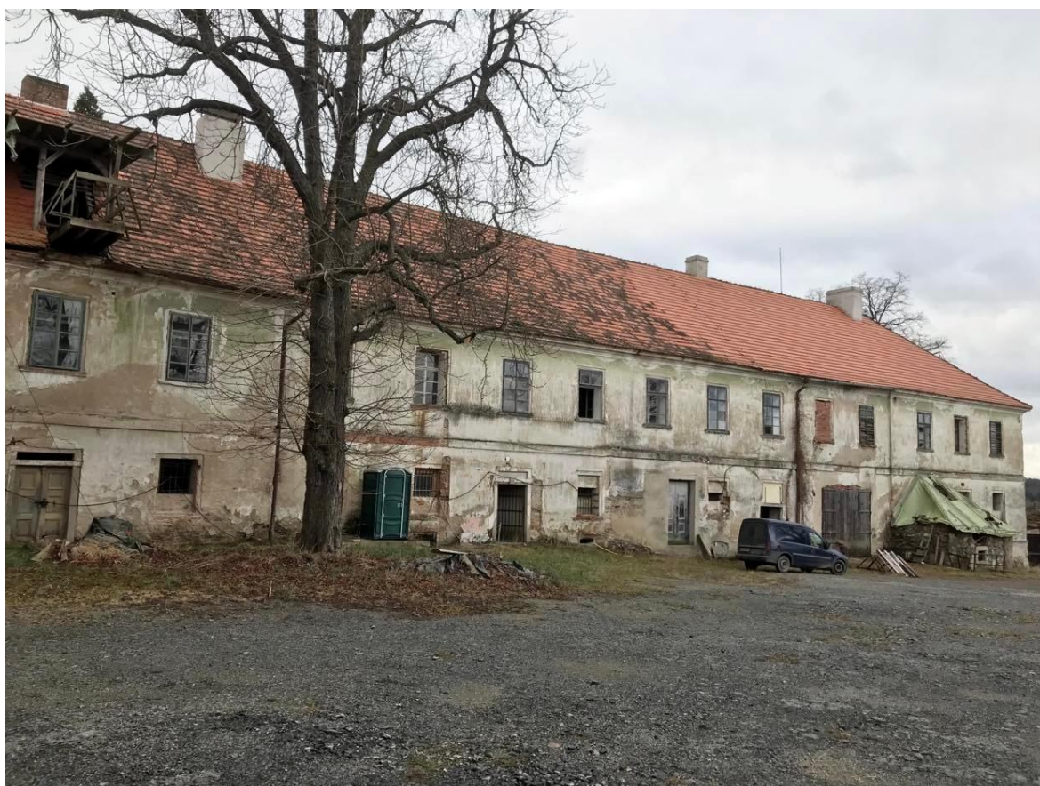
Obr. č. 63 Budova bývalého pivovaru, která přímo navazuje na zámek.
