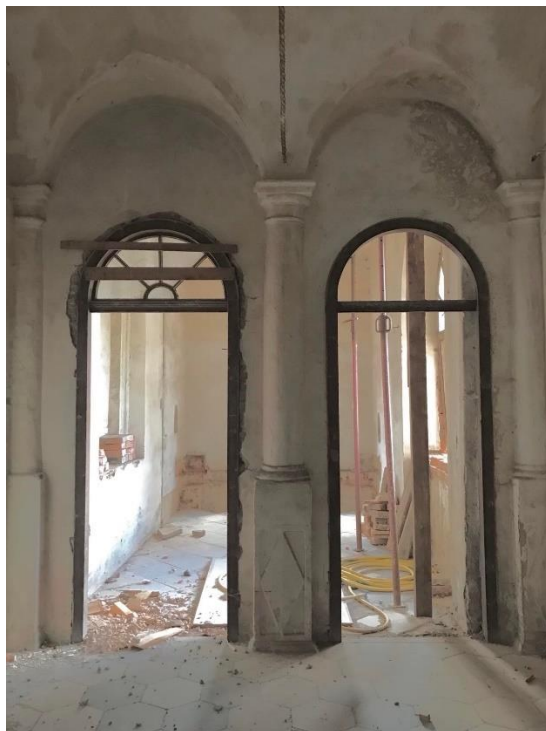
Obr. č. 14 Pohled z chodby se schodištěm, která propojuje hlavní a kratší křídlo. Je zde vidět včlenění původně vnějších arkád do vnitřku stavby. Za nimi se nachází část budovy přistavěná v 2. pol. 19. století.
