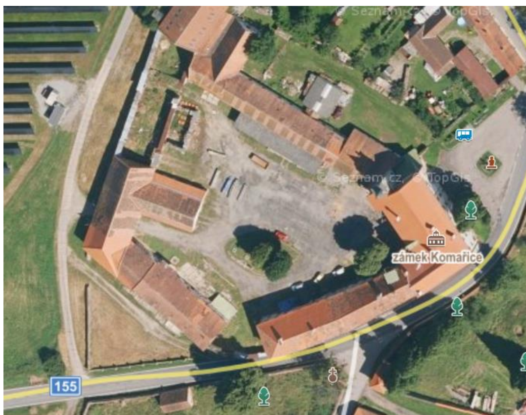
Obr. č. 61 Pohled na rozložení hospodářského dvora z výšky.
