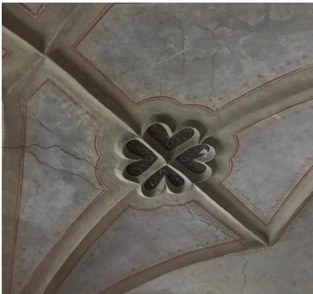
Obr. č. 38 Kvadrilob v klenbě chodby prvního patra.
