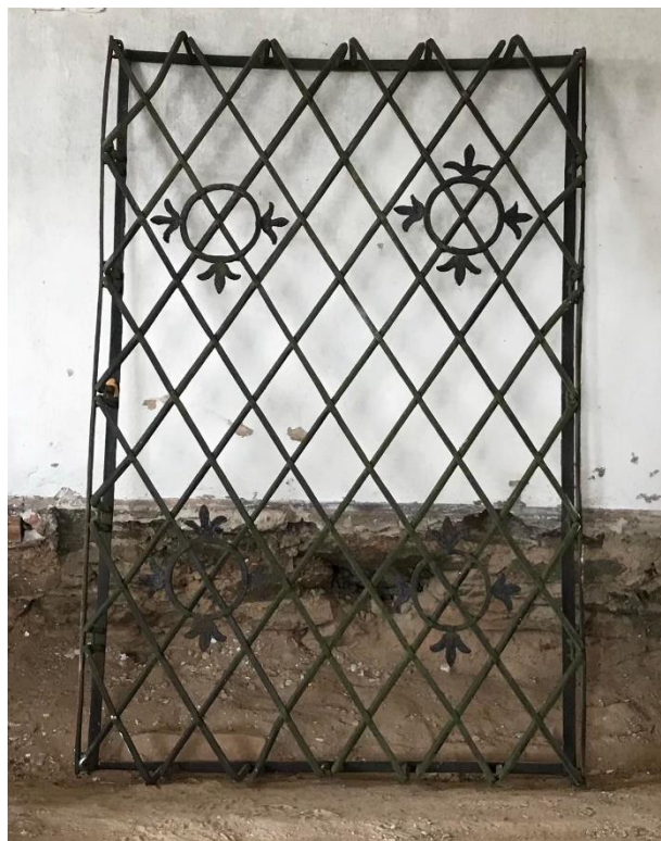
Obr. č. 33 Jedna z okenních mříží, která dnes zůstává v interiéru stavby.
