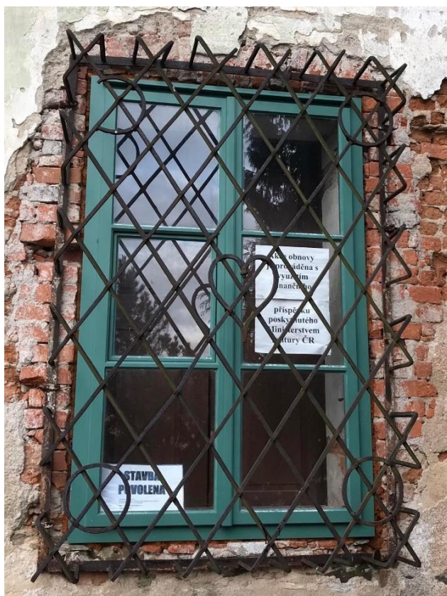
Obr. č. 31 Mříž umístěna na jihovýchodním nároží východní fasády hlavního křídla. Mříž má stejný motiv jako ta předchozí, ale v detailech se liší.
