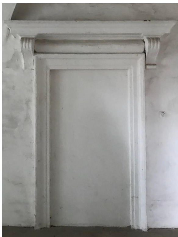
Obr. č. 51 Zazděný volutový portál. Takovýchto vstupních portálů se nachází v prvním a druhém patře zámku celý soubor. Kde přesně se nachází je zakresleno na plánech interiéru obr. (35, 36) jako dvě svislé čáry podél vstupu.
