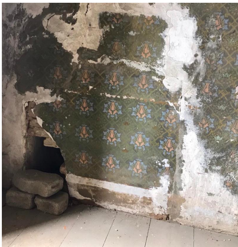
Obr. č. 9 Odkrytí zazděného topeniště v prostorách zámecké kaple.
