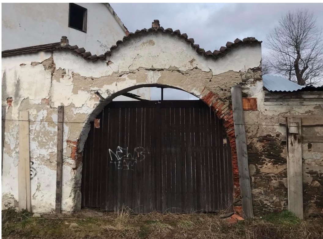
Obr. č. 64 Barokní vjezdová brána uzavírající obvod dvora zřejmě pochází z druhé poloviny 18. století.
