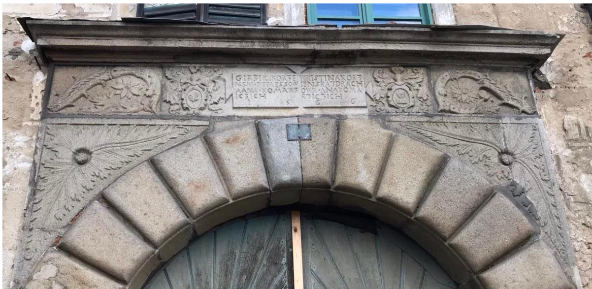
Obr. č. 18 Detail kamenických prací provedených nad vstupním obloukem hlavního portálu.
