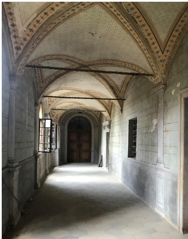
Obr. č. 48 Pohled do arkádové chodby v prvním patře. Zajímavá je iluzivní výmalba na stěnách, která napodobuje skutečné architektonické prvky tak, aby dosáhla symetrie. Tak jako v ostatních podlažích jsou v této chodbě dobře viditelná renesanční kroucená táhla.
