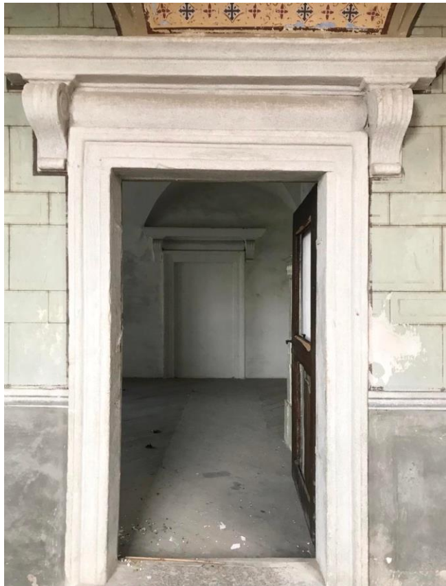
Obr. č. 52 Na zámku se dochovalo velké množství volutových renesančních portálů. Některé z nich jsou dnes zazděné. Tento portál vede z arkádové chodby v prvním patře do jedné z obytných místností.
