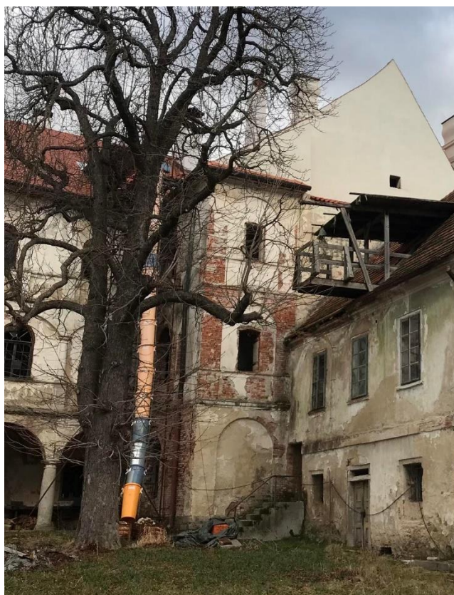
Obr. č. 25 Pohled na dvorní průčelí bočního křídla, k němuž byl v 19. století přistavěn trakt. Trakt je k hlavní budově přidružen přiloženou pultovou střechou.
