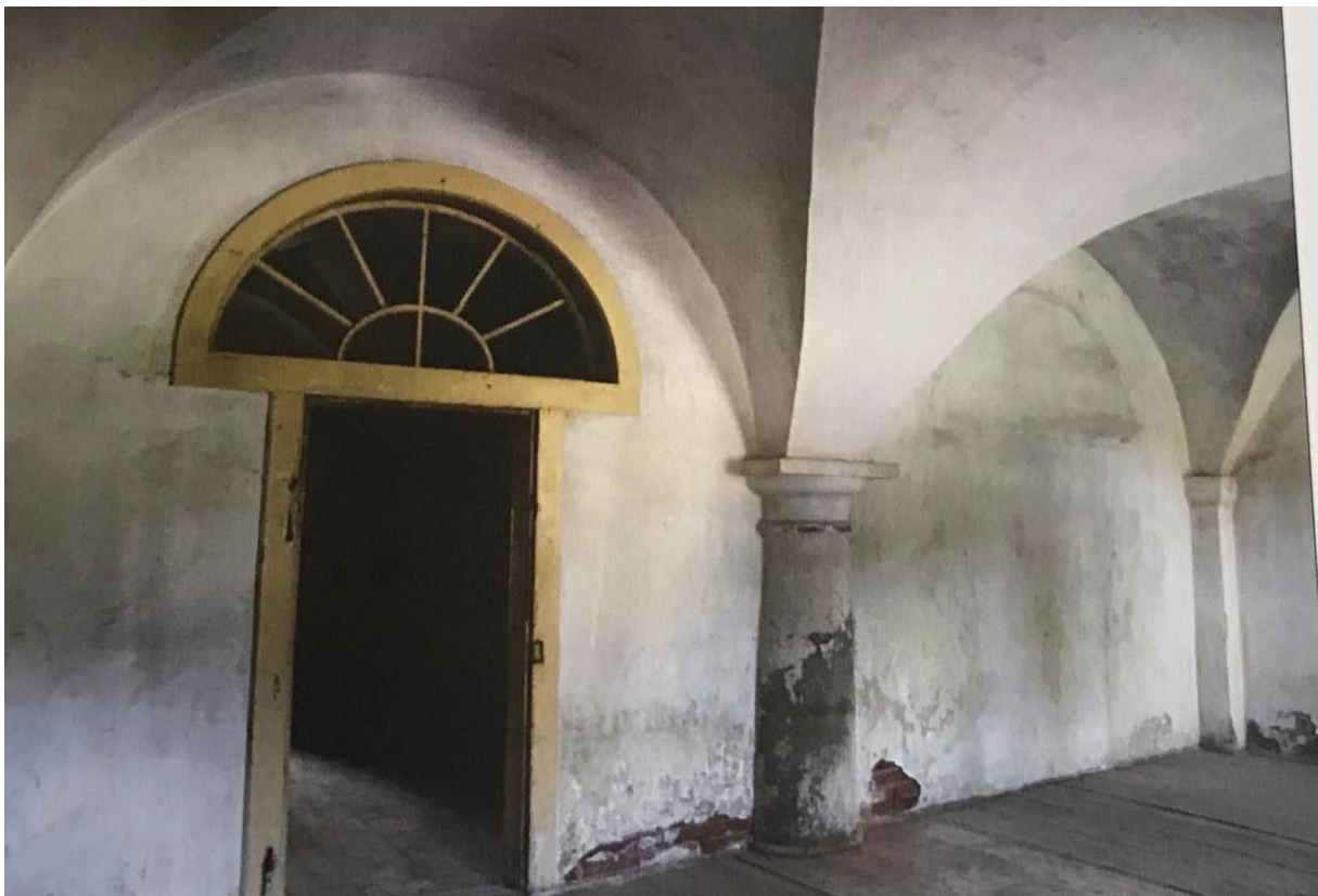
Obr. č. 37 Původně rozlehlá přijímací síň se středovým toskánským sloupem je dnes rozdělena klasicistními příčkami.
