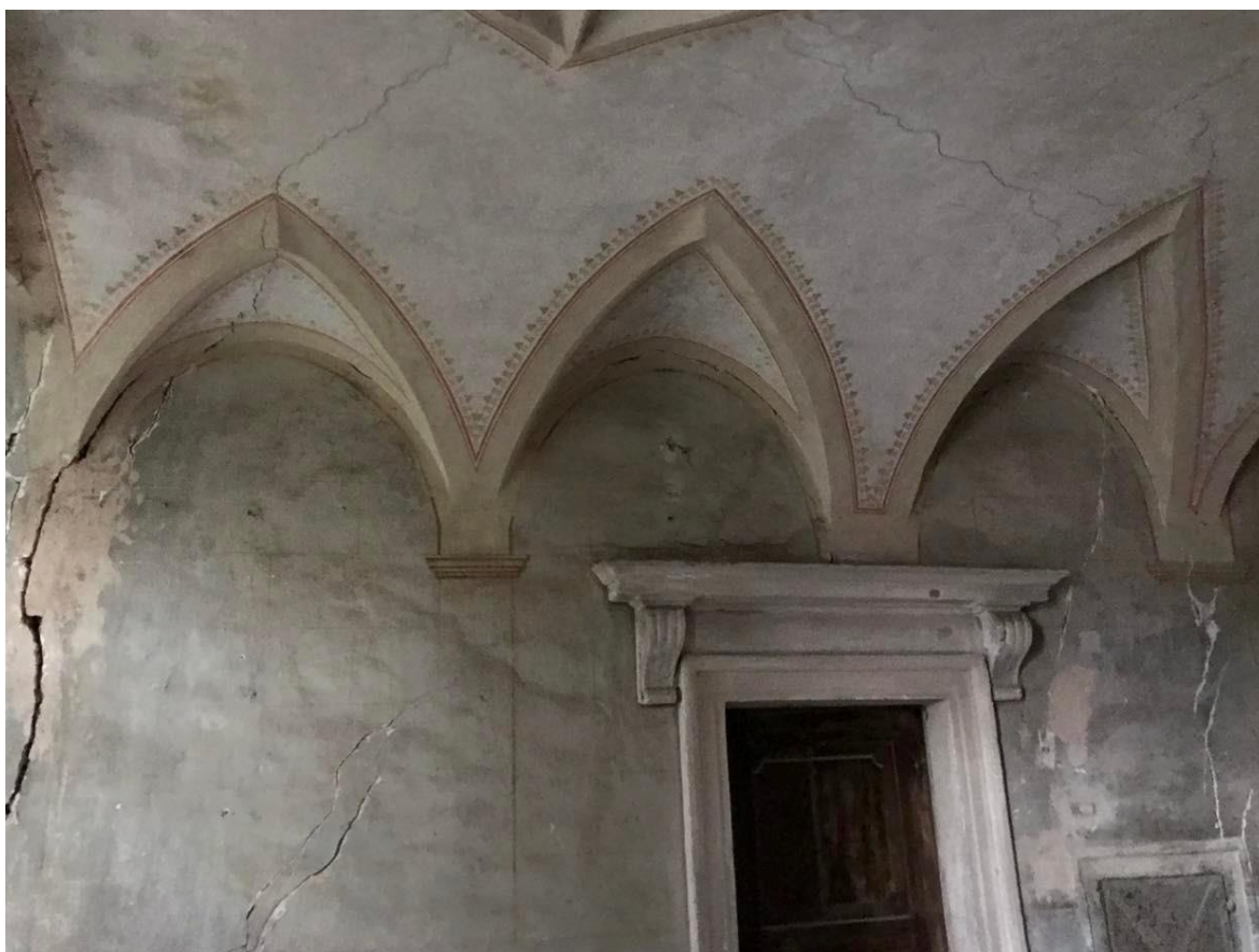
Obr. č. 40. Chodba propojující hlavní a boční křídlo. Stejně jako většina chodeb na zámku je zaklenuta valenou klenbou se sledem trojbokých výsečí. Mimo to ji zdobí výmalba z 2. pol. 19. století.
