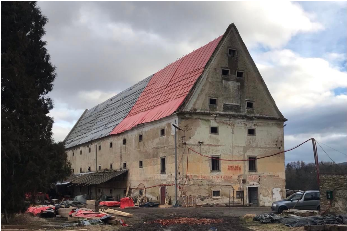
Obr. č. 73 Štítové průčelí sýpky. V prázdném zapadlém poli ve štítu se zřejmě dříve mohl nacházet znak.
