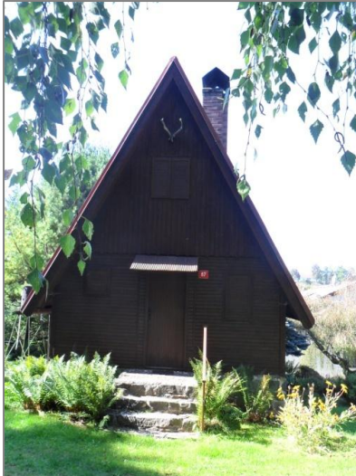
Foto 4 Stanová střecha – Dobronice u Bechyně (Havlová, R. 2012)
