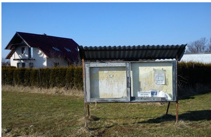
Foto 23 Původní nástěnka v chatové osadě, dnes zchátralá a zřídka využívaná (Havlová, R. 2012)
