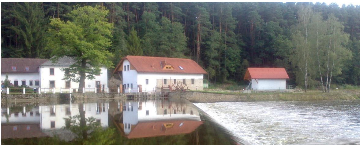
Foto 11 Oplocená vodní elektrárna u Červeného Mlýna – zabránění přístupu ke korytu (Havlová, R. 2012)
