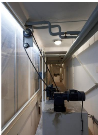
Obr. 62: Mies, vila Tugendhat, strojovna pro technické spouštění oken
