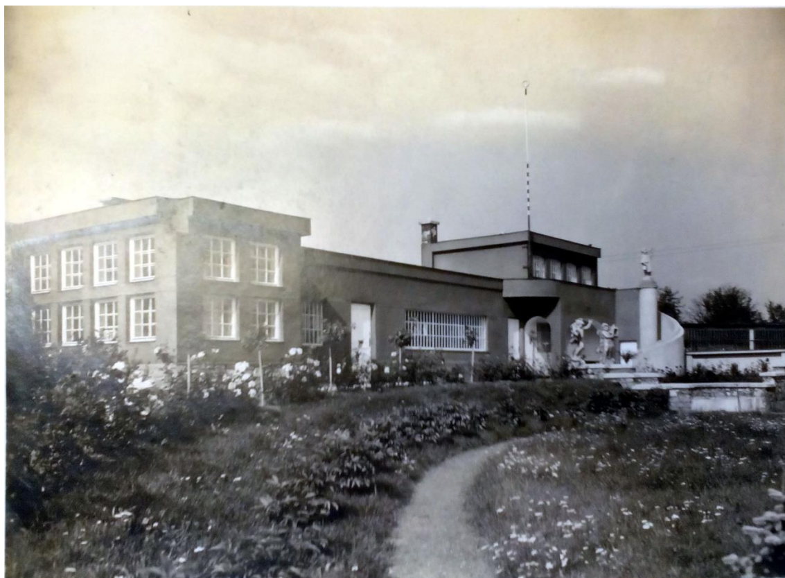
[16] Hubert Aust: Rodinný dům manželů Drábkových v Olomouci, 1924, 1926, 1927, 1929, dílenská budova pana Drábka
