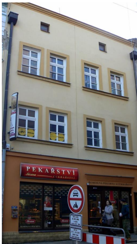
[65] Hubert Aust: Adaptace domů F. a M. Čtvrtečkových a M. Bořkovcové, 1937, současný stav fasády
