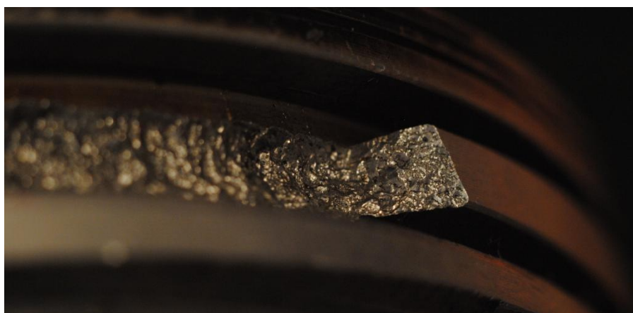
Obr. 8 Druhý můstek v místě poškození
