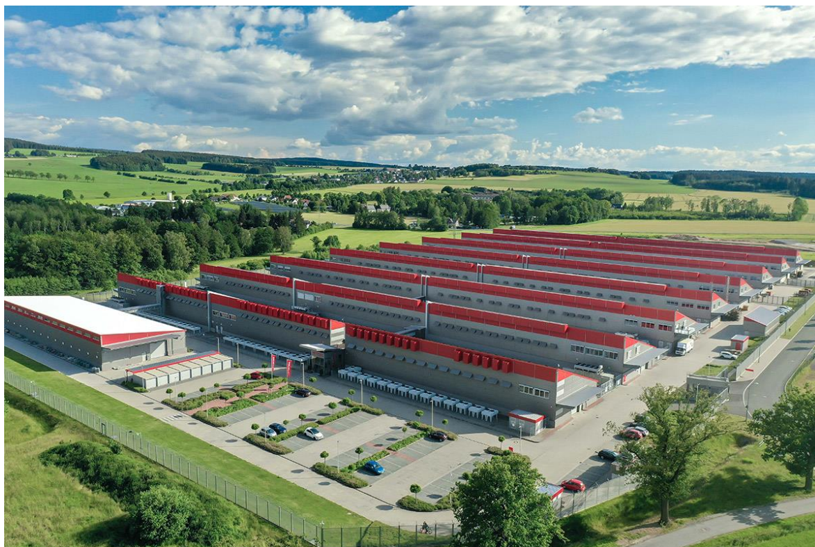
Obrázek 20: Datové centrum ve městě Falkenštejn
