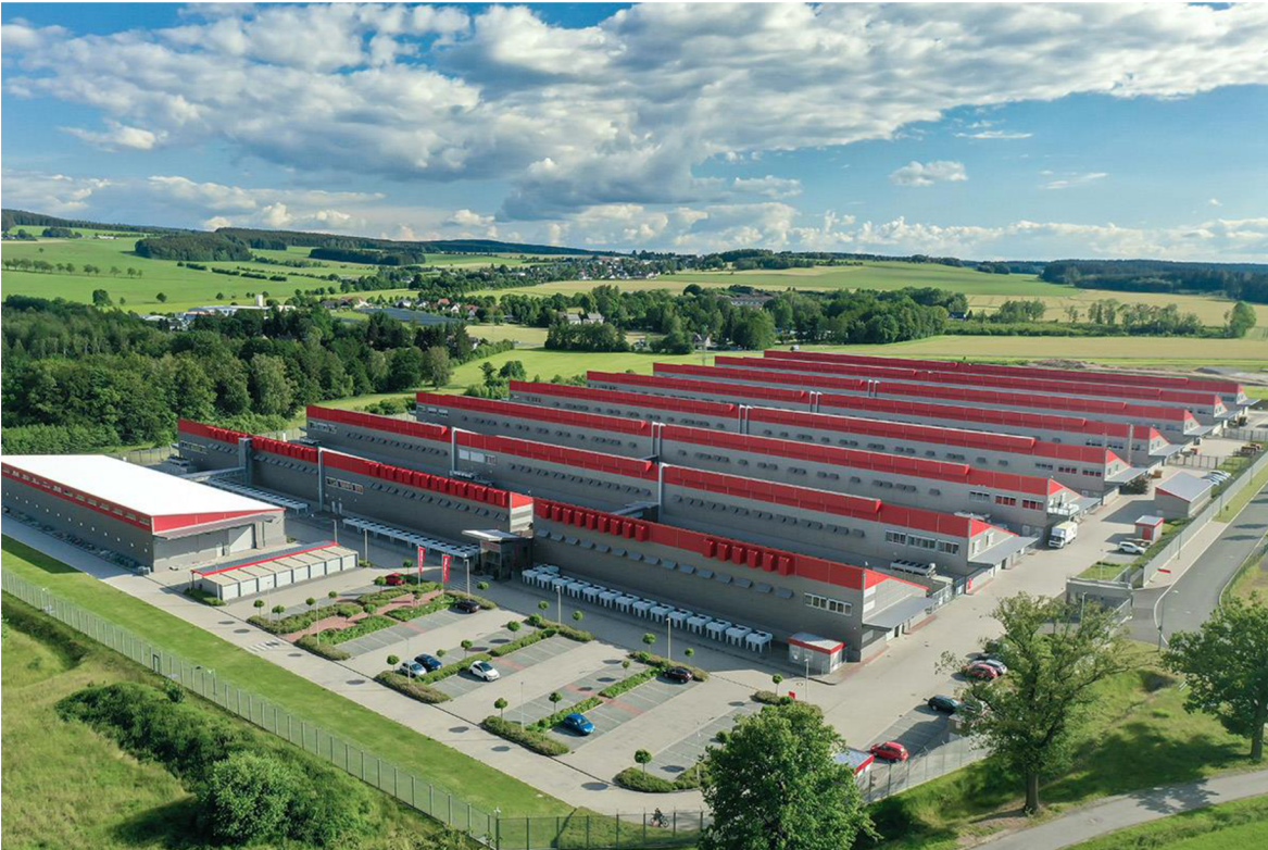
Obrázek 20: Datové centrum ve městě Falkenštejn
