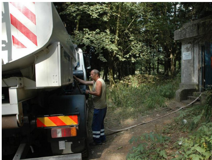
Obrázek 4-21 - Plnění vodojemu v Němci z cisterny [55]
