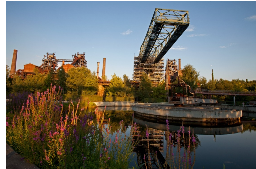
Obr. 13: Landschaftspark - Duisburg-Nord: Konverze bývalých hutí do podoby parku při zachování historicky hodnotných industriálních konstrukcí (zdroj: http://www.juttariegel.com/wp-content/uploads/2015/11/IMG_00691-1920x1280.jpg )
