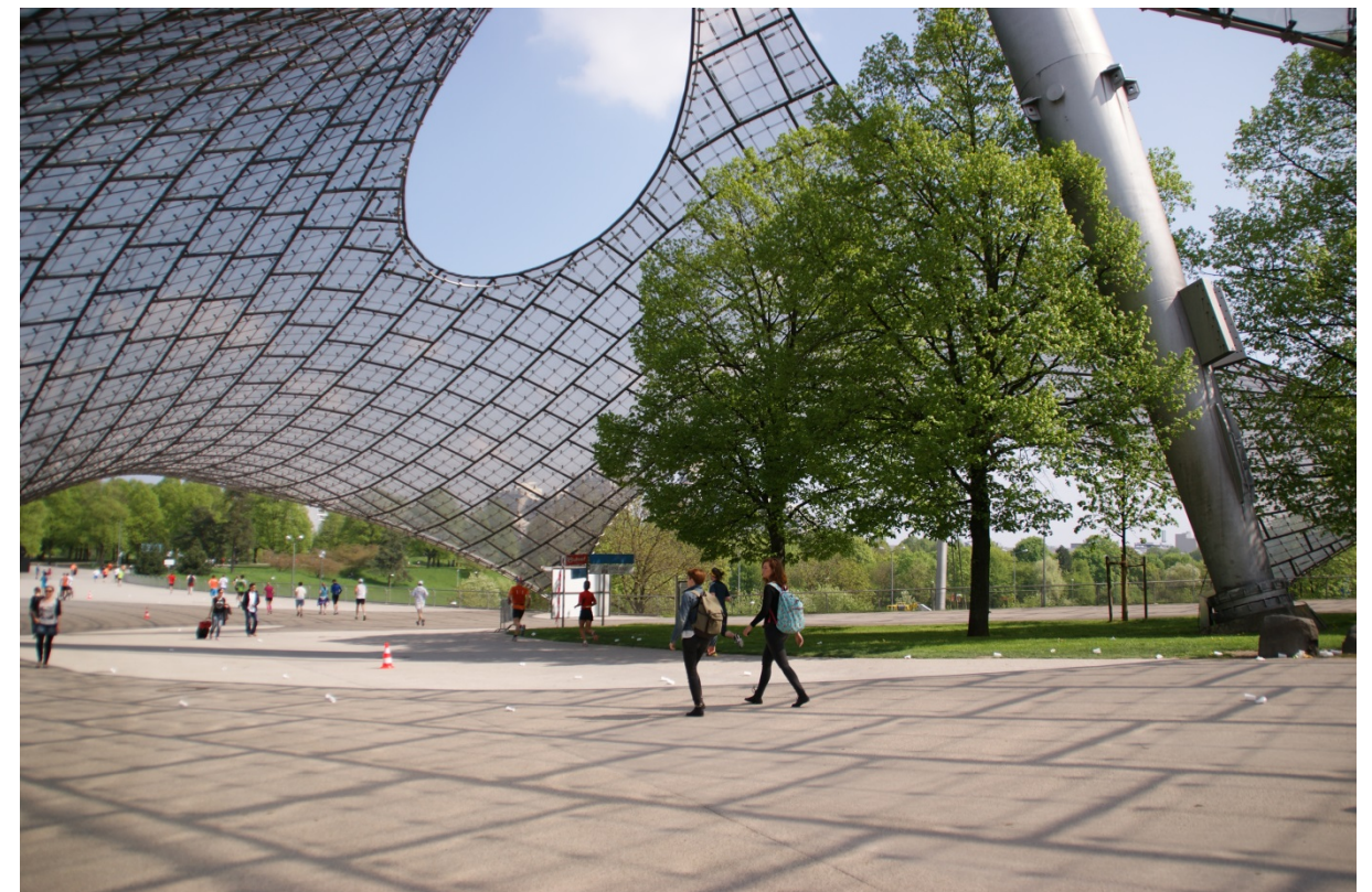
Obr. 20: Olympijský stadion se zcela nezaměnitelným tvaroslovím konstrukce (zdroj: archiv autora)
