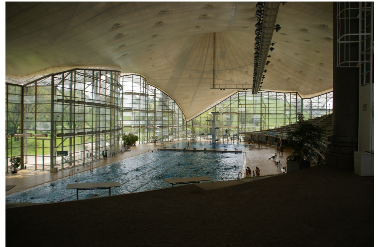
Obr. 19: Interiér stadionu pro vodní sporty (zdroj: archiv autora)
