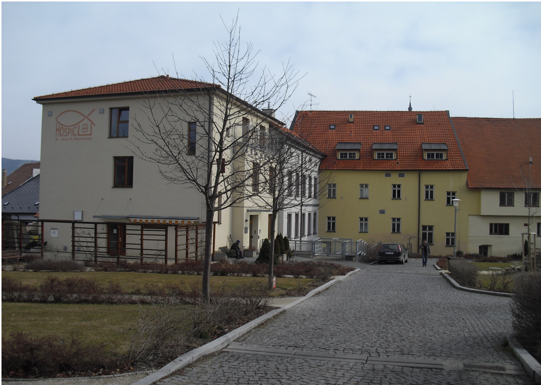
Hospic sv. Jana N. Neumanna (zadní část rodného domu s novou přístavbou)
