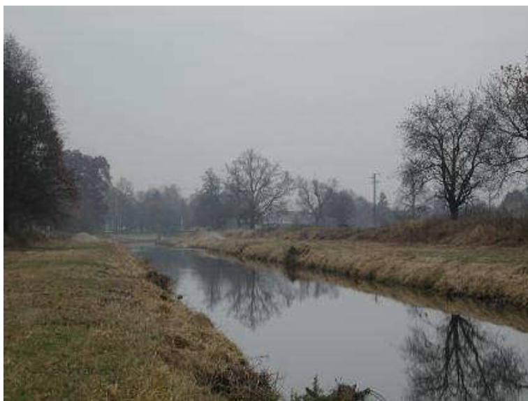
Obr. č. 11 Úpravy na dolním toku Blanice – úprava profilu koryta: lichoběžníkový profil s výškou protipovodňového valu do 1,5 m (úsek od Vodňan po soutok s Otavou) (Foto: M. Šobr)
