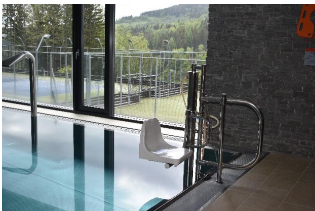
Obr. 44 Bazén - hydraulický sedák
