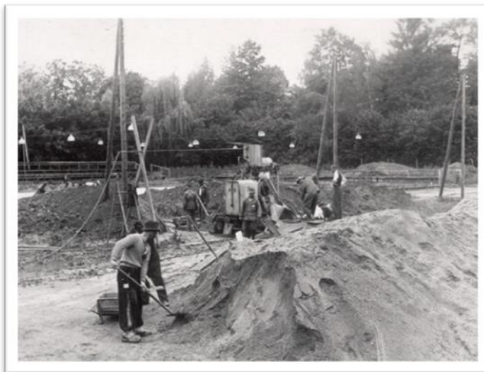
Obrázek 22. Stavební práce na zimním stadionu v Hájčku. Fotografie převzata z knihy Lhota, L. (2010). Velký příběh českobudějovického hokeje . Krnín: Růže, s. 50.
