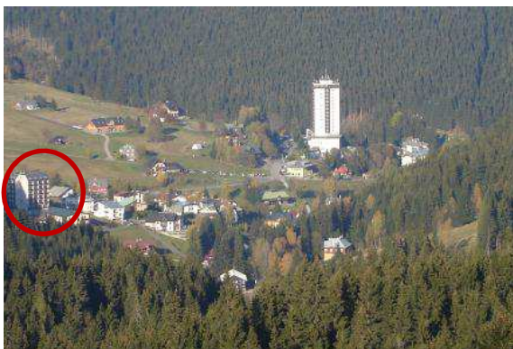
Obr. 26 Vlevo betonová stavba na Malé Pláni
