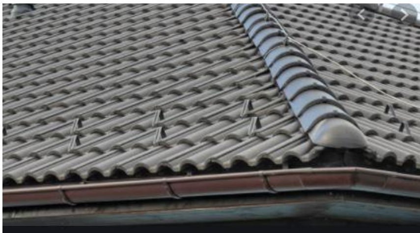
obr. 3 Betonová střešní krytina [32]
