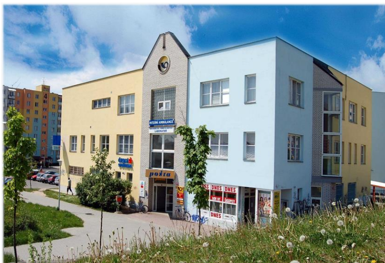
Obrázek 4: Česká pošta v Českých Budějovicích – ulice Ant. Barcala
