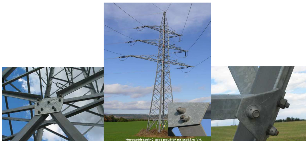
Obr. 3.5 NŠS na stožáru po montáži
