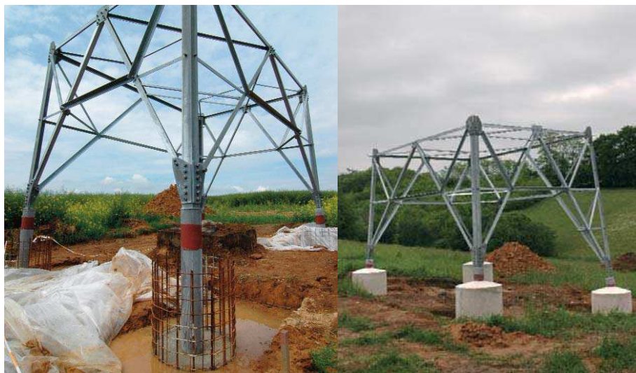
Obr. 2.1 Základový díl stožáru [1]
