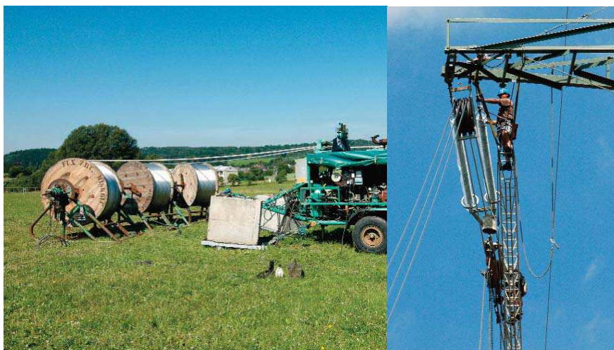
Obr. 2.3 Montáž vodičů [1]
