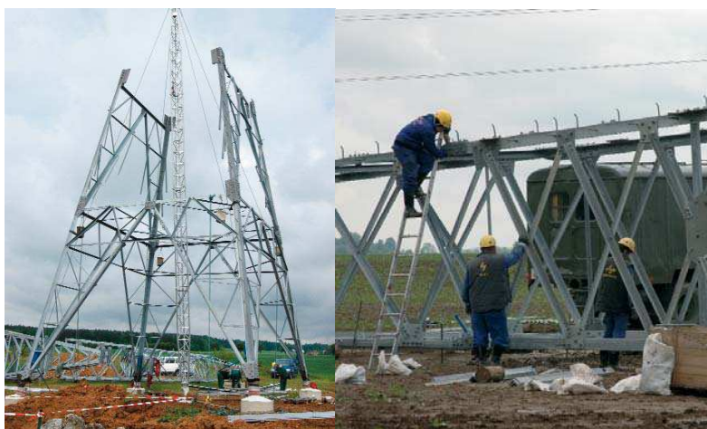
Obr. 2.2 Montáž stožáru [1]
