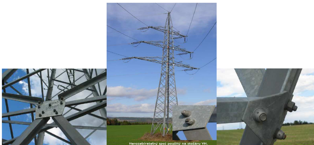
Obr. 3.5 NŠS na stožáru po montáži
