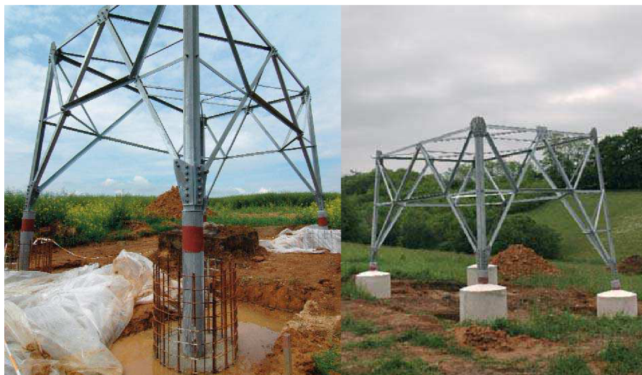
Obr. 2.1 Základový díl stožáru [1]
