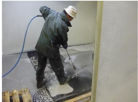
Obr. 7.14 Tryskanie vodou.
