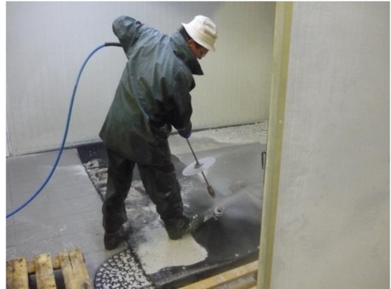
Obr. 7.14 Tryskanie vodou.
