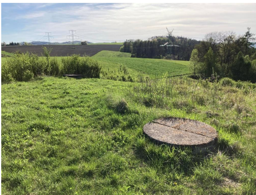
Obr. 16: Skruž na horní ploše bývalé skládky TKO Zábřeh
