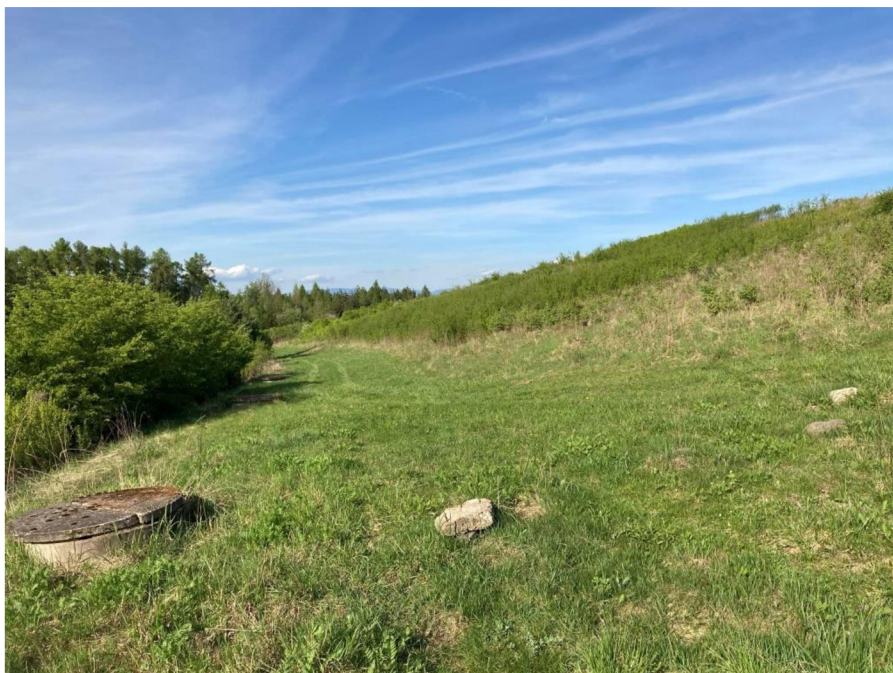
Obr. 15: Skruže pod bývalou skládkou TKO Zábřeh
