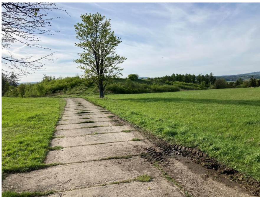
Obr. 18: Příjezdová cesta ke skládce TKO Zábřeh
