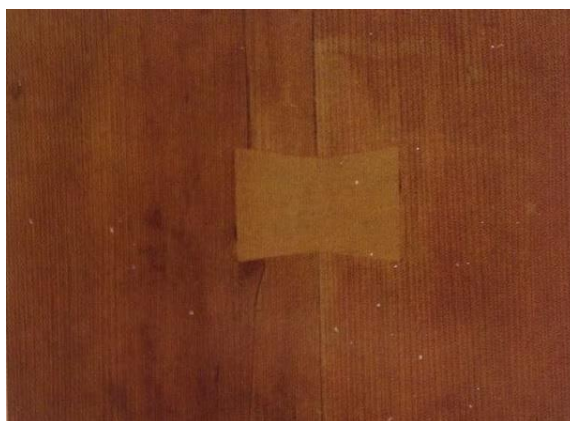
Obrázek 2: Historicky používané spoje; motýlkový spoj, zdroj: [3]
