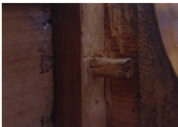
Obrázek 3: Historicky používané spoje; kolíčkový spoj, zdroj: [3]
