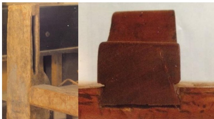
Obrázek 1: Historicky používané spoje; z pravé strany svlakový, z levé čepový spoj, zdroj: [3]
