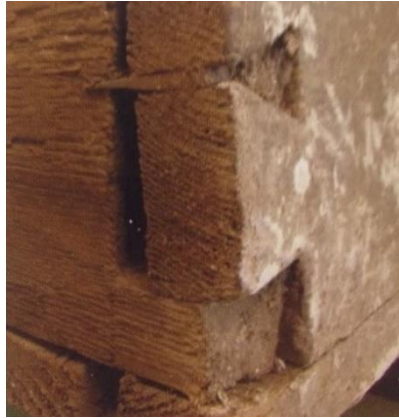
Obrázek 4: Historicky používaný spoj; rybinový nekrytý spoj, zdroj: [3]
