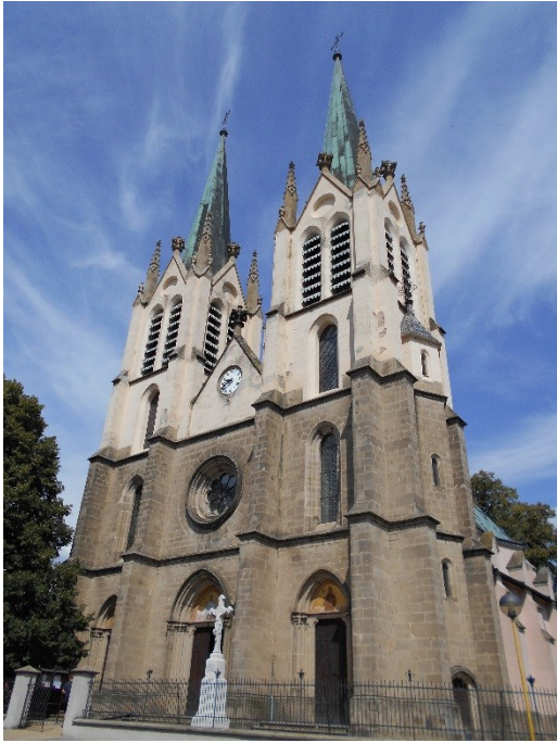
65. Kostel svatého Petra a Pavla, 1881–1884, Rataje, pohled od jihozápadu.
