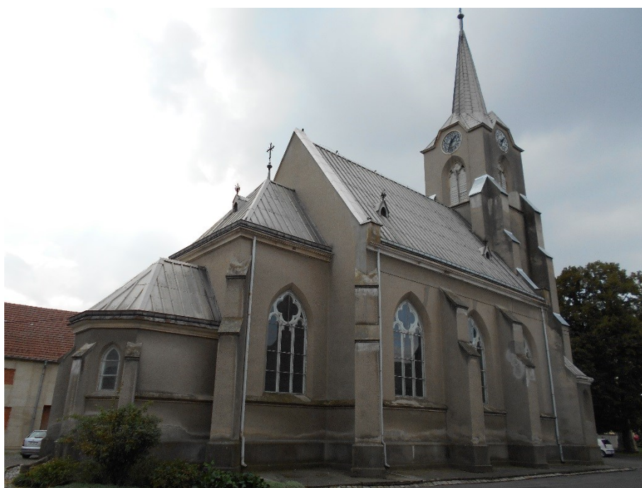
76. Kostel svatého Jana Nepomuckého, 1885–1887, Křenovice, pohled od severovýchodu.
