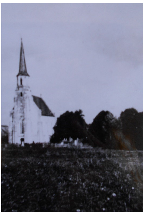
42. Kostel svatého Ondřeje, 1869–1871, Slezské Pavlovice, pohled od jihozápadu, dobová fotografie, nedatováno.
