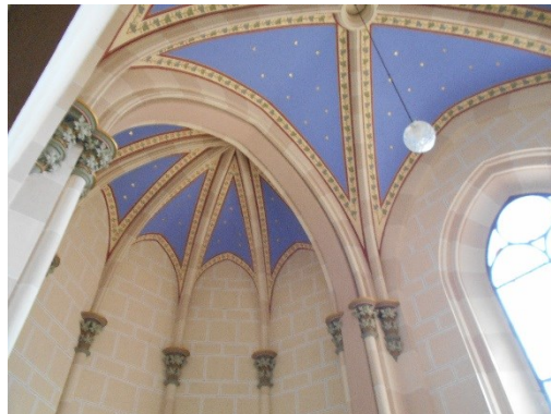
72. Kostel svatého Petra a Pavla, 1881–1884, Rataje, klenba sakristie.
