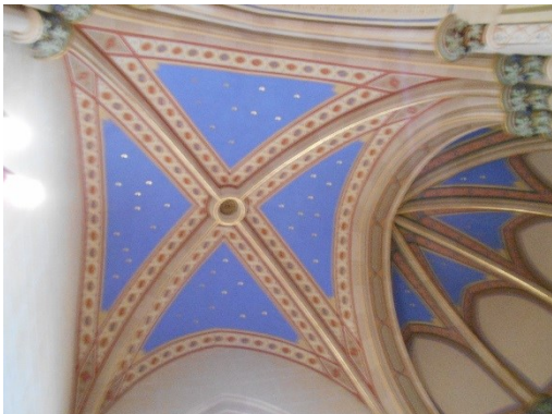
71. Kostel svatého Petra a Pavla, 1881–1884, Rataje, klenba kaple.
