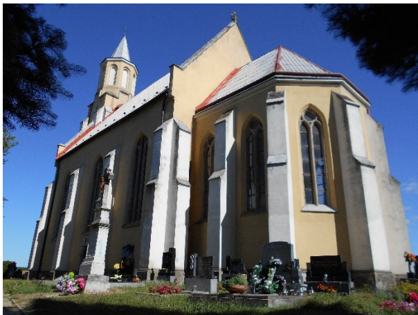
31. Kostel svatého Ondřeje, 1869–1871, Slezské Pavlovice, pohled od jihovýchodu.
