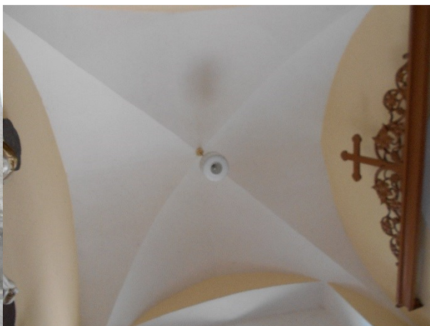
78. Kostel svatého Jana Nepomuckého, 1885–1887, Křenovice, klenba podvěží.
