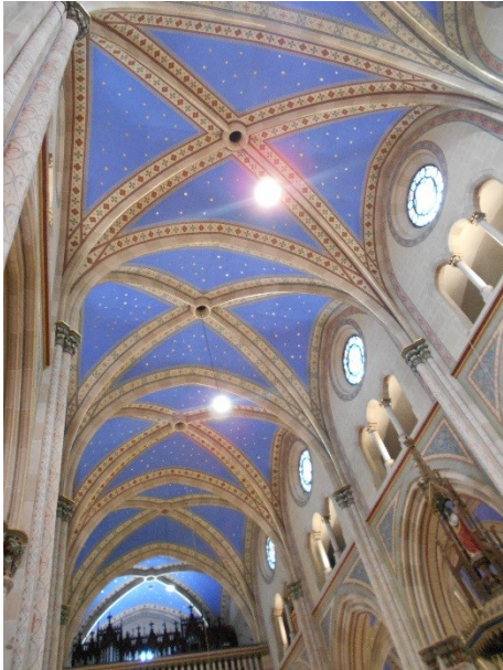
69. Kostel svatého Petra a Pavla, 1881–1884, Rataje, klenba hlavní lodi.
