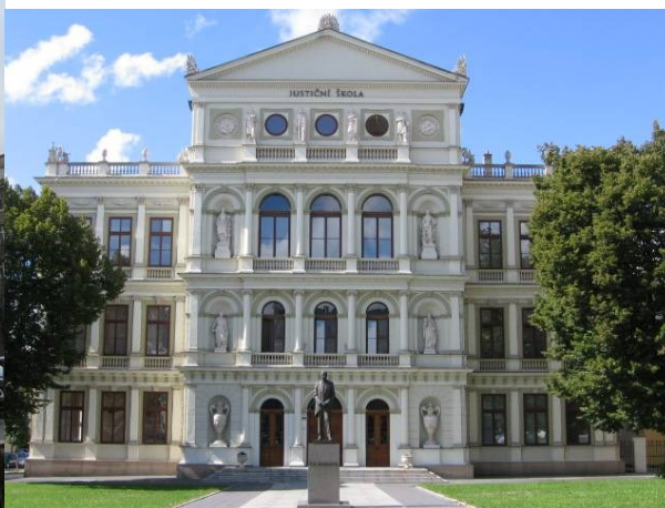
85. Justiční akademie (bývalá reálka), 1875–1877, Kroměříž, pohled od jihovýchodu.
