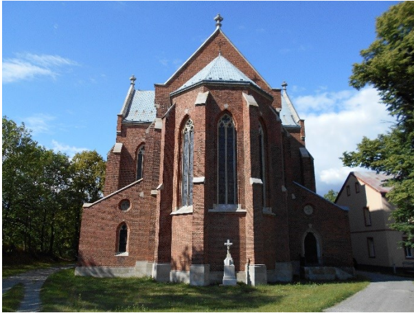
19. Kostel Nanebevzetí Panny Marie, 1865–1870, Liptaň, pohled od jihu.
