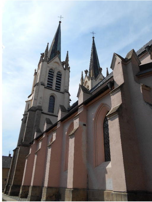
66. Kostel svatého Petra a Pavla, 1881–1884, Rataje, pohled od východu.
