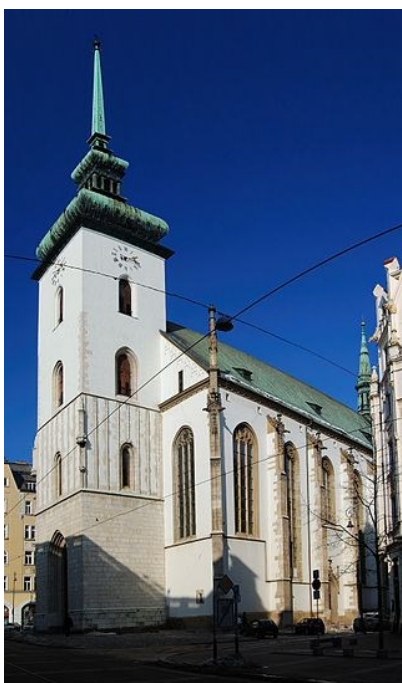
5. Kostel sv. Jakuba Staršího, pol. 15. století–1592 (dostavba věže), regotizace 1871–1879, Brno, pohled od jihozápadu.
