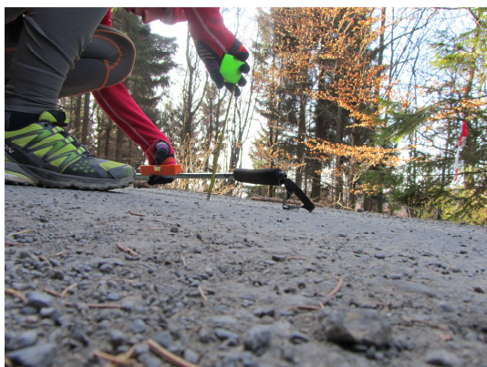
Měření příčného sklonu
