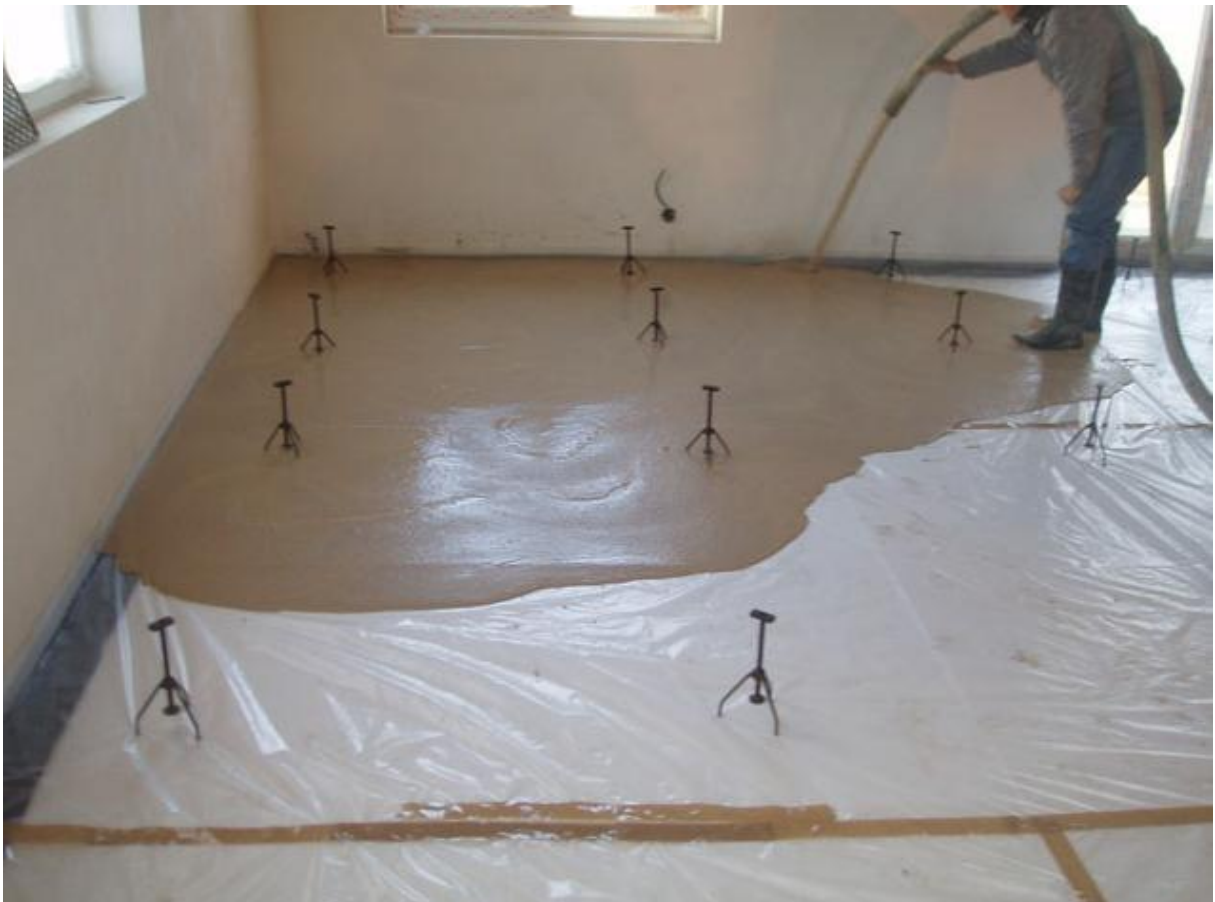
Obr. 5: Pokládka samonivelační anhydritové podlahy
