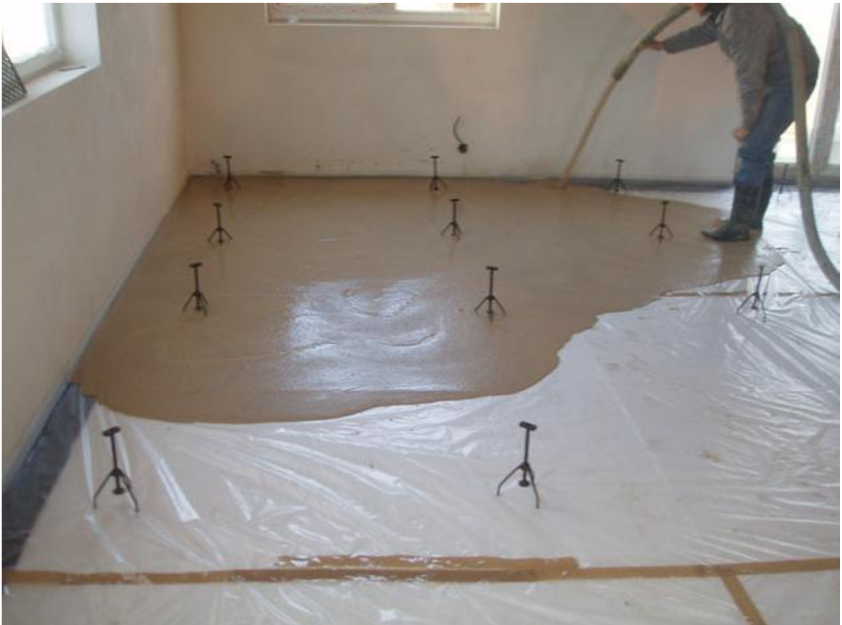
Obr. 5: Pokládka samonivelační anhydritové podlahy
