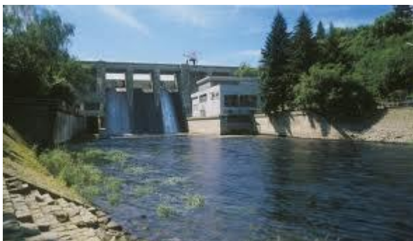
Obrázek č. 3 Malá vodní elektrárna
