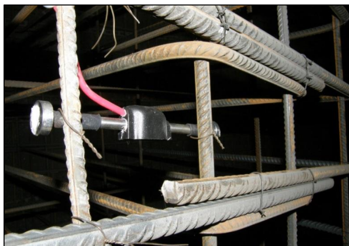
Obr. 5.6: Královopolské tunely v Brně, strunový tenzometr nachystaný v armatuře sekundárního ostění před betonáží
