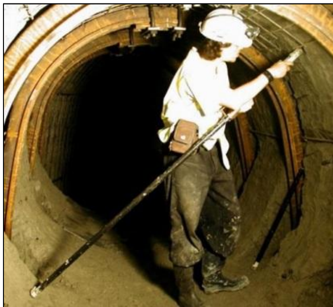
Obr. 2.19: Průzkumné štoly Královopolských tunelů v Brně, měření konvergenčního profilu tyčovým konvergometrem [17]
