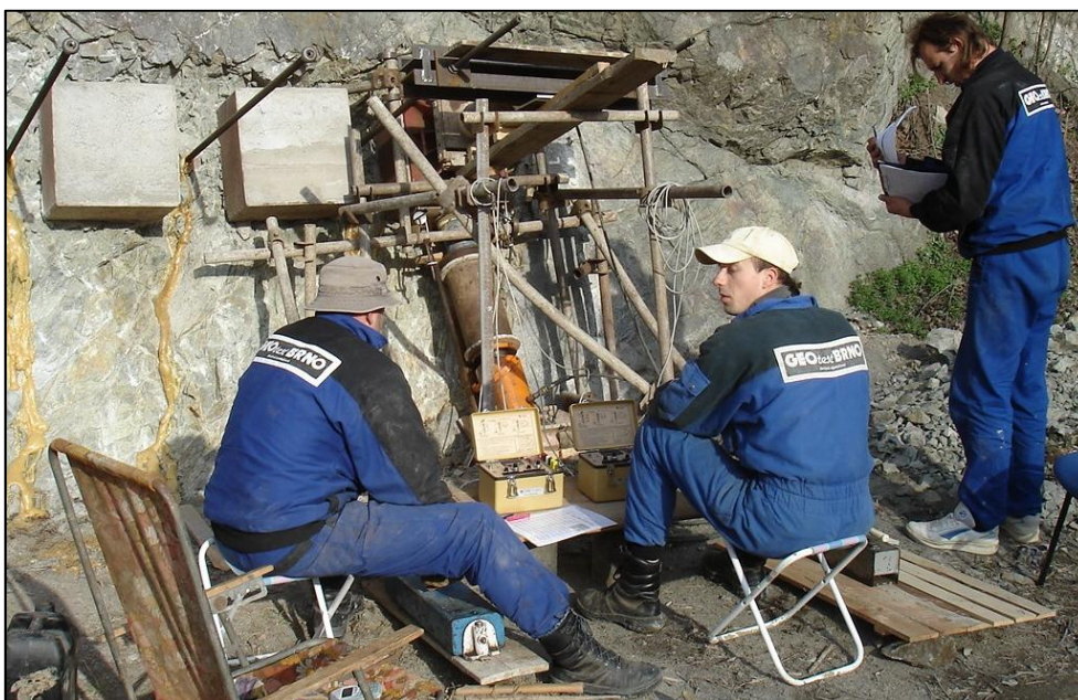
Obr. 2.25: VMO Žabovřeská Brno, provádění smykových zkoušek
