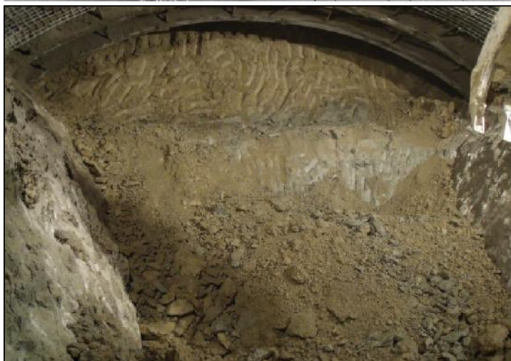
Obr. 5.3: Královopolské tunely v Brně, geologická dokumentace čelby [16]
