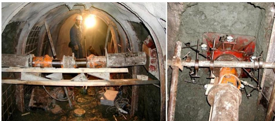
Obr. 2.21: Průzkumné štoly Královopolských tunelů v Brně, sestava polní zatěžovací zkoušky v rozrážce [17]
