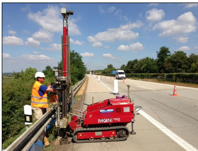
Obr. 2.15: Dálnice D2, km 29, provádění penetračních sond, souprava PAGANI TG150
