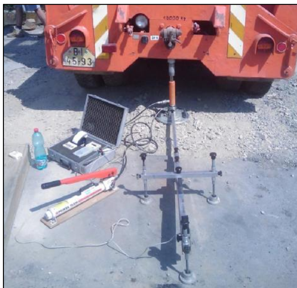
Obr. 2.29: Rosice, provádění statické zatěžovací zkoušky deskou
