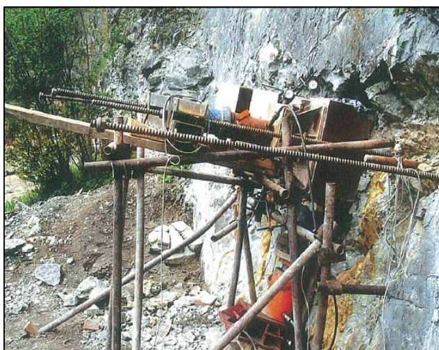
Obr. 6.9: VMO Žabovřeská Brno, sestava polní smykové zkoušky S3 [18]
