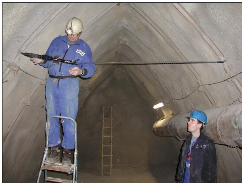
Obr. 5.5: Královopolské tunely v Brně, průzkumné štoly, měření konvergencí v malém výrubu pomocí konvergenčního pásma (zdroj: GEOTest, a.s.)
