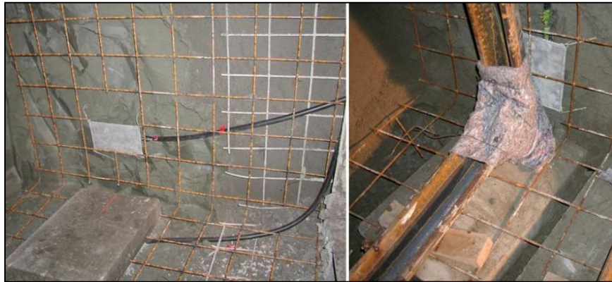
Obr. 6.36: Osazení tlakové podušky v ostění [17]
