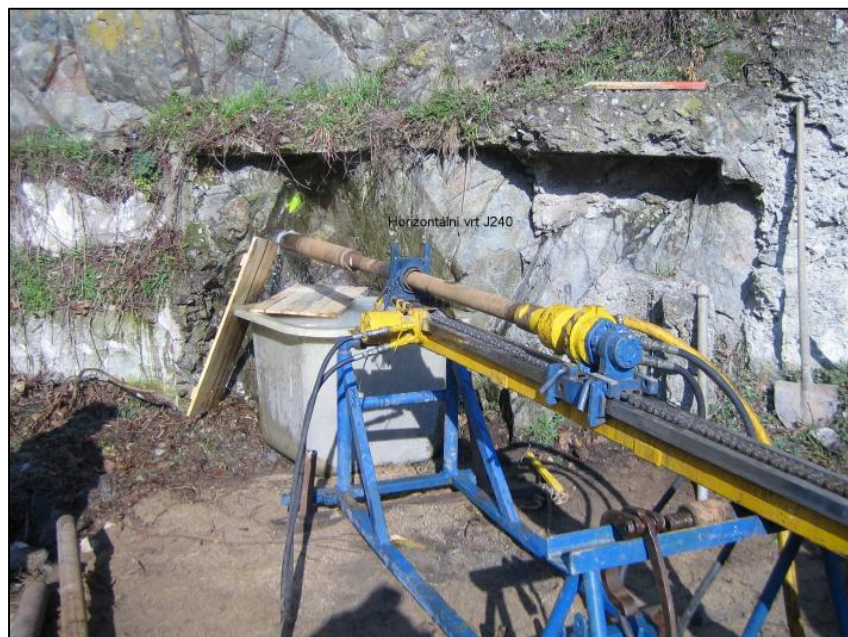
Obr. 6.4: VMO Žabovřeská Brno, realizace horizontálního vrtu J240 [18]
