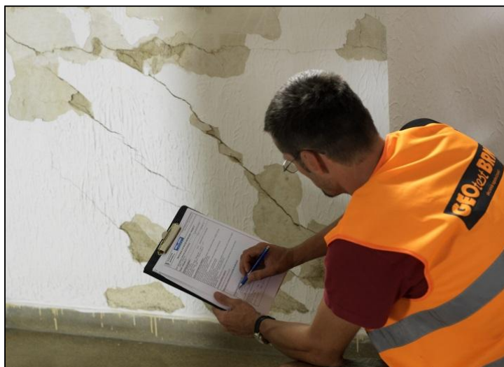
Obr. 5.12: Královopolské tunely v Brně, sledování změn stavu objektu (zdroj: GEOTest, a.s.)
