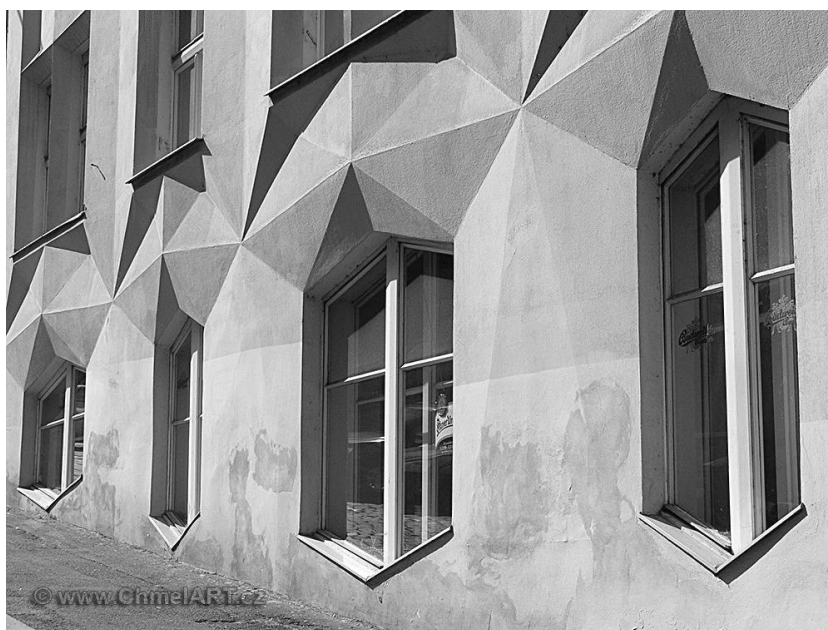
16. Chocholův dům v Neklanově ulici – detail
