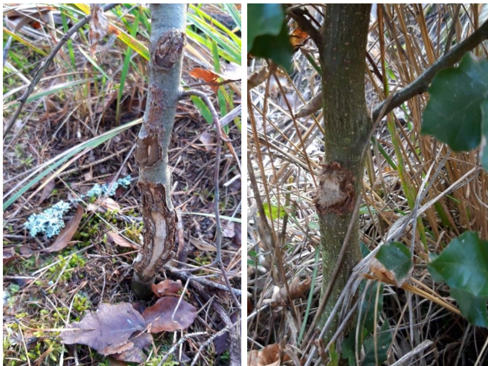
Obr. 24 Poškození sazenic při provádění mechanického ničení buřene ZP č. 1
