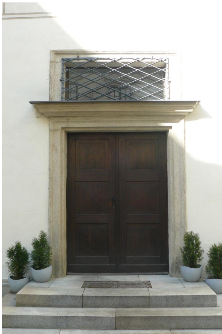
(e) Ostění dveří v nádvoří zámku, foto: autorka.
