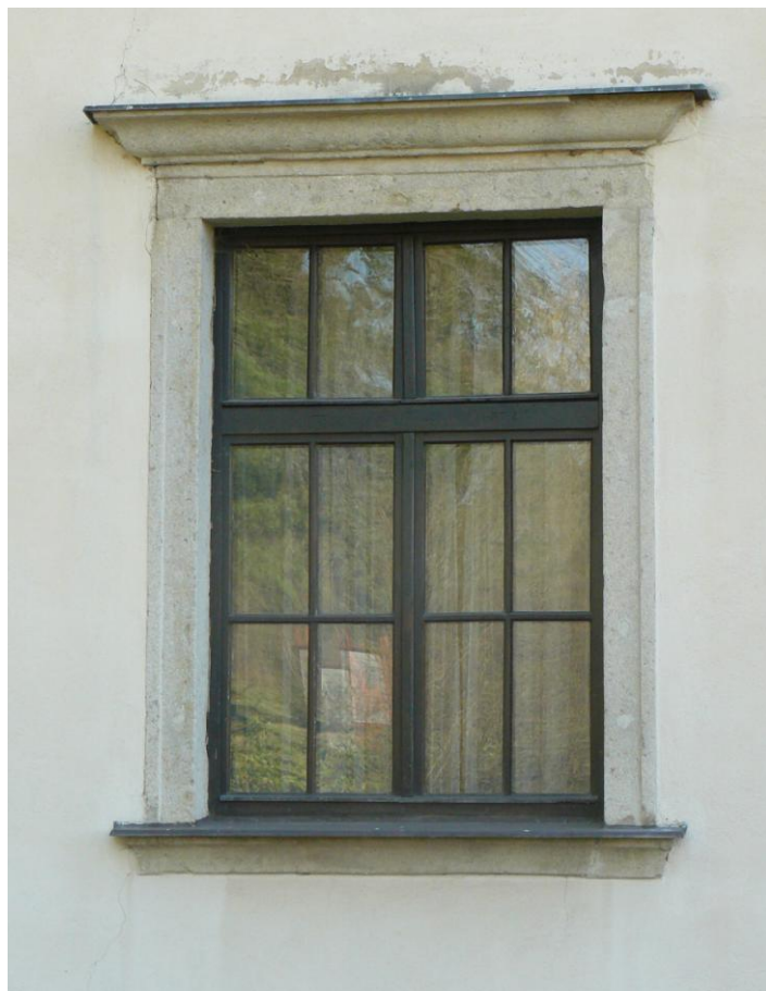
(a) Ostění okna v 1. patře severního křídla zámku, foto: autorka.
