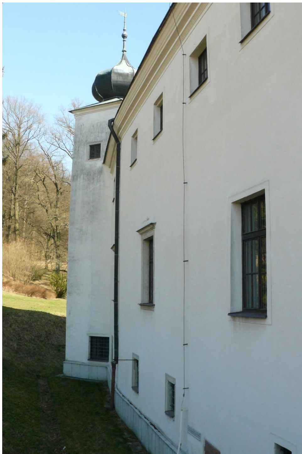
(a) Zalomení severního křídla zámku, foto: autorka.
