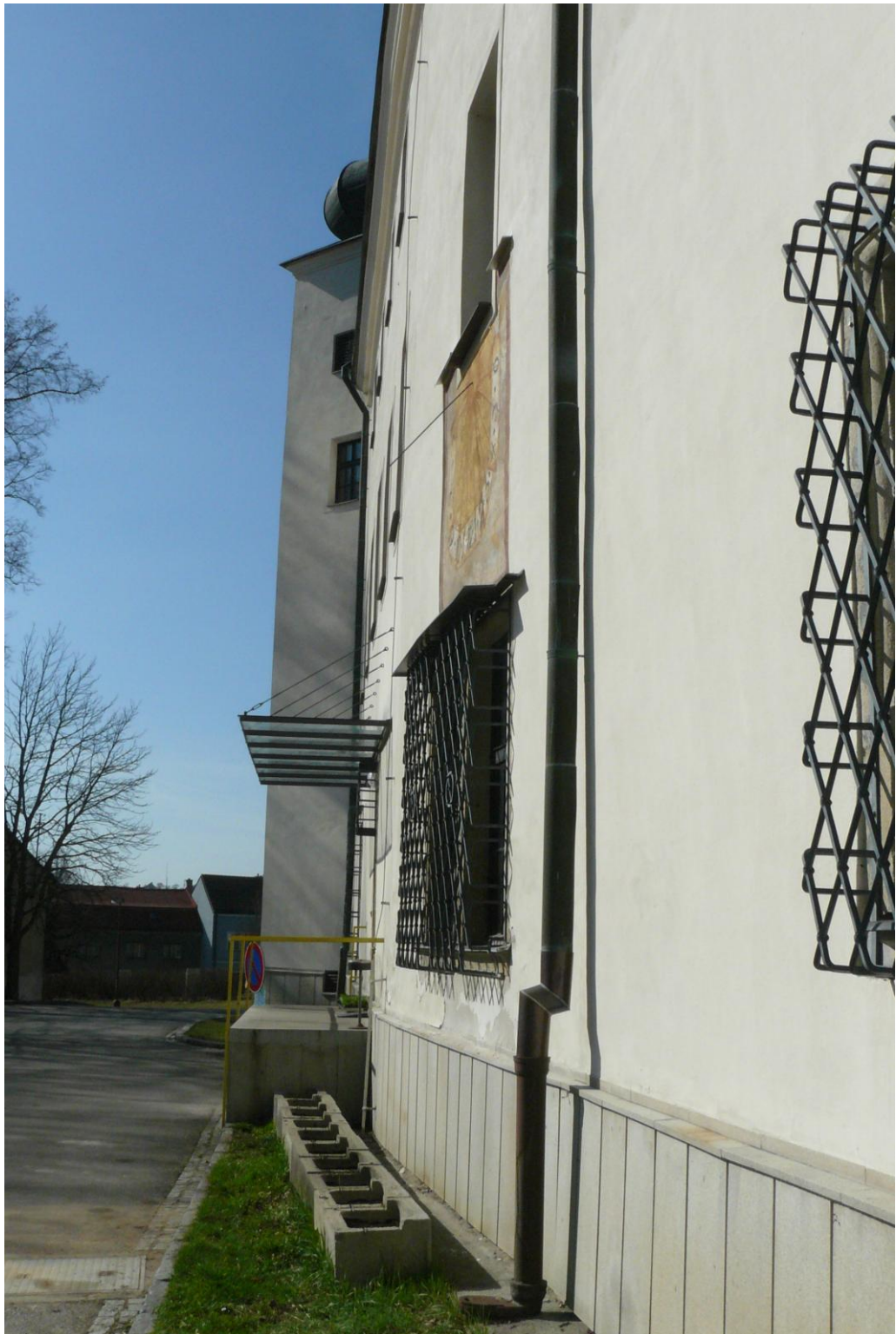
(b) Zalomení jižního křídla zámku. Podle M. Plačka je zakřivení typické pro pozdně středověké stavby (M. PLAČEK, Ilustrovaná encyklopedie... , s. 651), foto: autorka.
