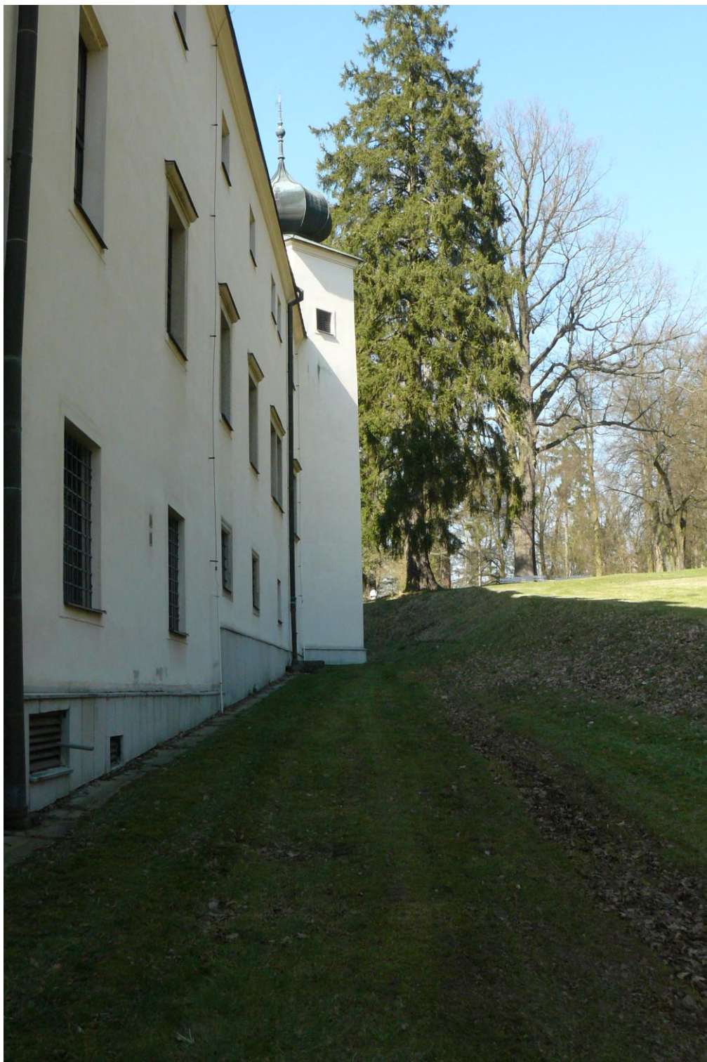
(a) Pozůstatky vodního příkopu u východního křídla zámku, foto: autorka.
