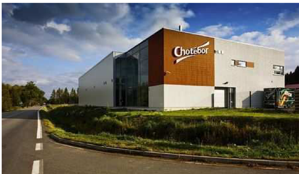
Obr. 4: Budova Pivovaru Chotěboř (18)
