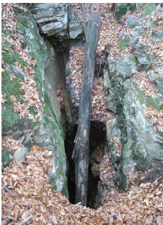
Obr. 27. Detail zavaleného ústí štoly na lokalitě Marie Pomocná III (foto: V. Bártková).
