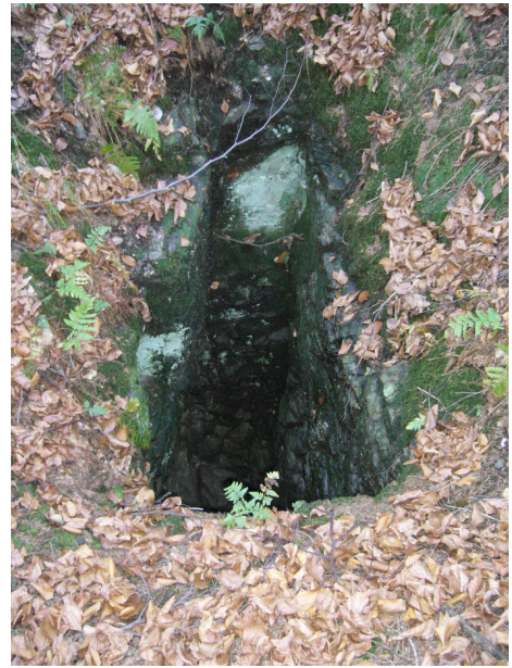
Obr. 22. Větrací komín na lokalitě Marie Pomocná I (foto: V. Bártková).
