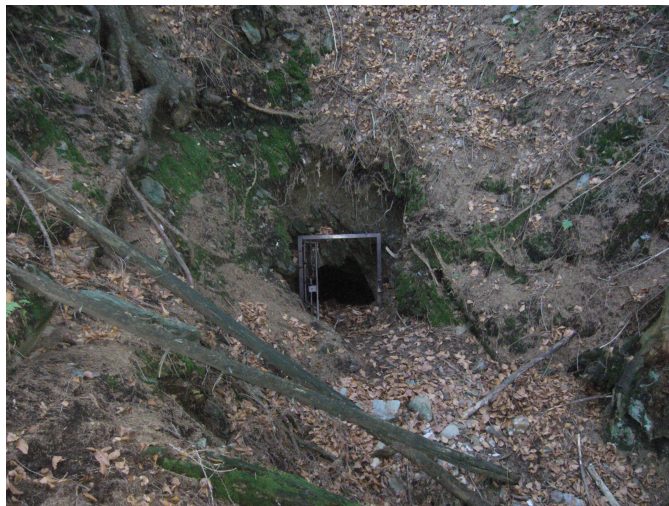
Obr. 23. Mříží osazené ústí štoly na lokalitě Marie Pomocná I (foto: V. Bártková).
