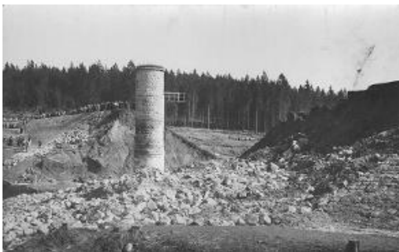
Obr. 18 Protržení přehrady Desná [50]
