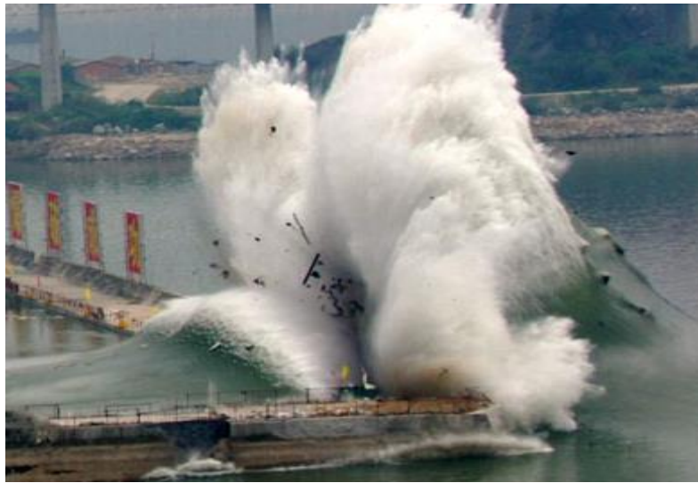
Obr. 20 Odstřel ochranné hráze hlavní opěrné zdi [56]
