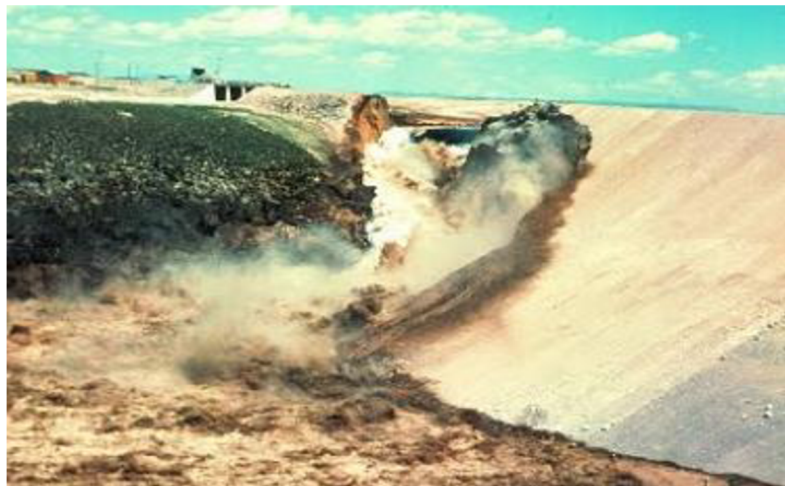
Obr. 17 Protržení přehrady Teton [49]
