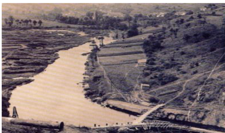
Obr. 22 Zahájení stavby Brněnské přehrady [62]
