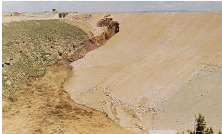
Obr. 16 Trhlina přehrady Teton [49]
