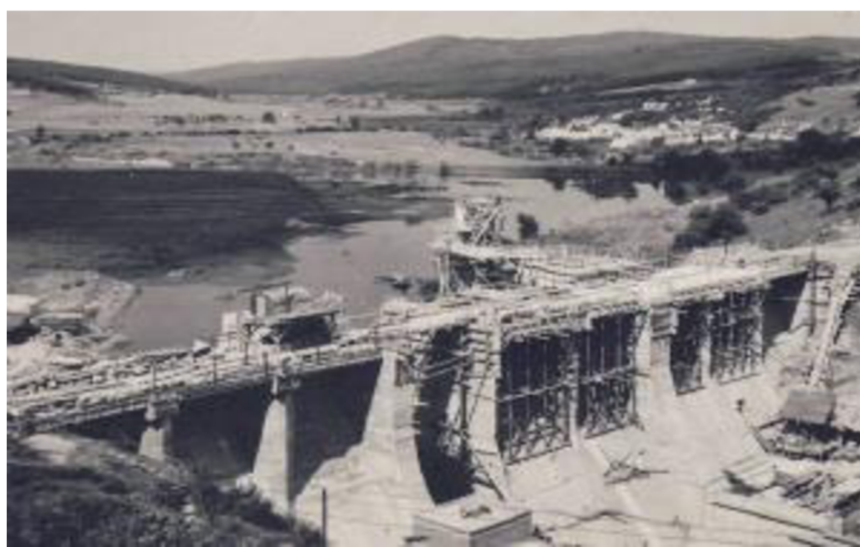
Obr. 23 Brněnská přehrada při výstavbě roku 1939 [62]
