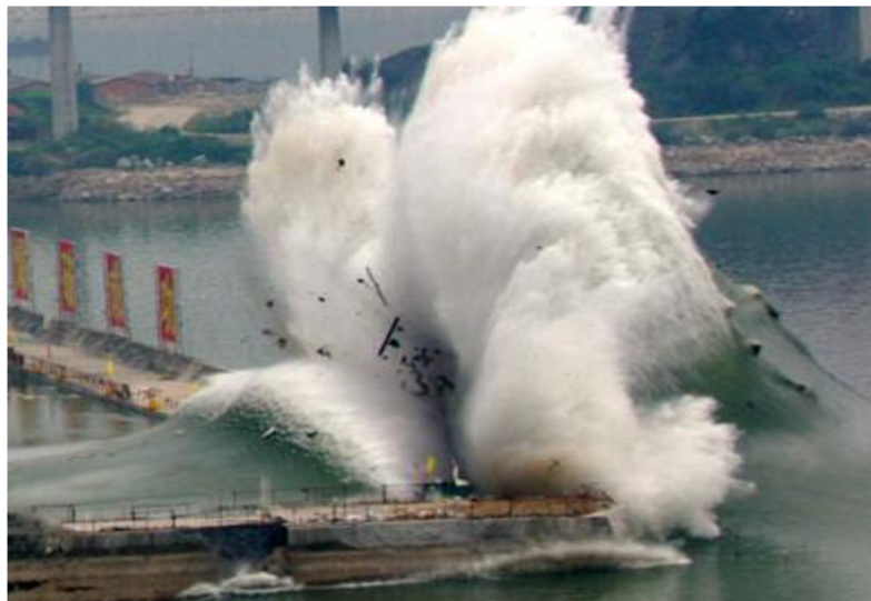
Obr. 20 Odstřel ochranné hráze hlavní opěrné zdi [56]
