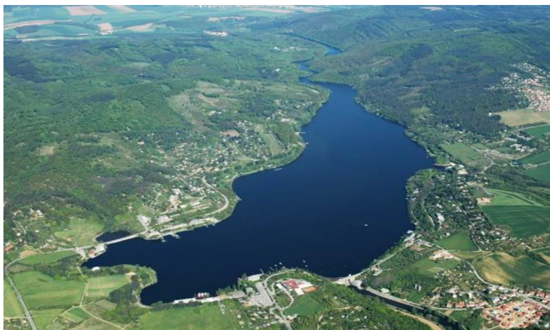
Obr. 21 Brněnská přehrada letecký pohled [61]
