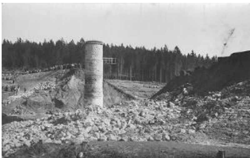
Obr. 18 Protržení přehrady Desná [50]
