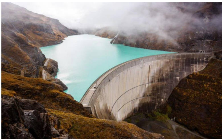
Obr. 1 Přehrada Mauvoisin, Švýcarsko [1]
